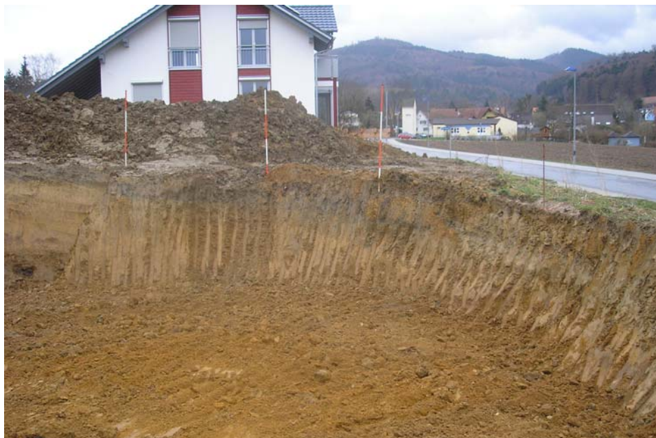
Abb. 5: Baugrube nördlich der General- von- Holzing- Straße, Bollschweil: Auehlm über Lösslehmlagen. Im Untergrund Ältere Schotter (Breisgauschichten).
