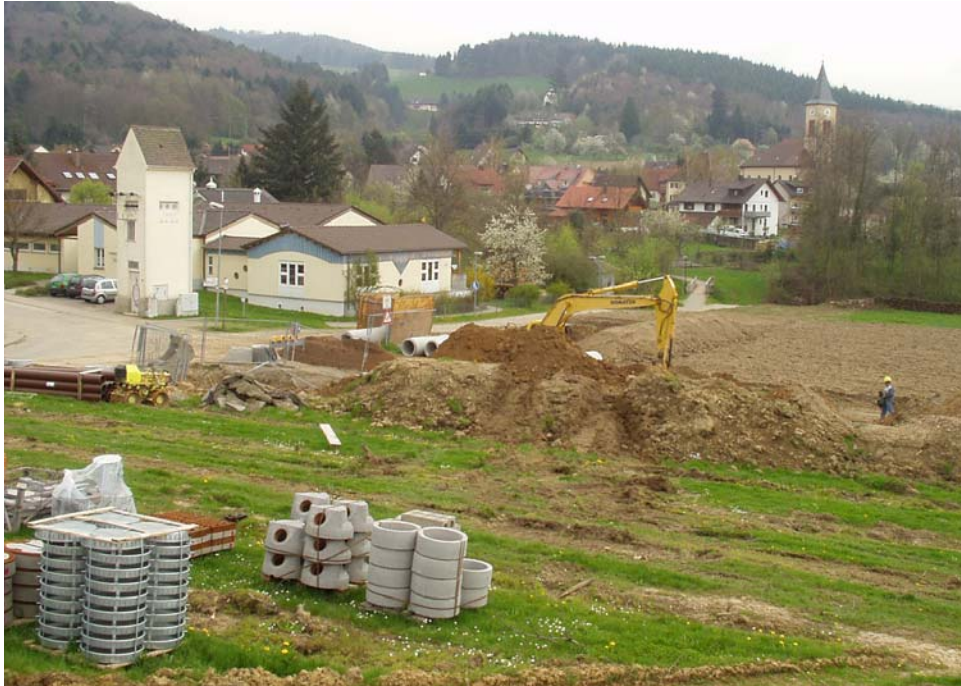
Abb. 2: Blick vom Baugebiet nach SO Richtung Oberdorf. Der Bereich unterhalb der Schachtringe bis zur Möhlin (erkenntlich an der Baumgruppe) wird von holozänen Auesedimenten eingenommen.
