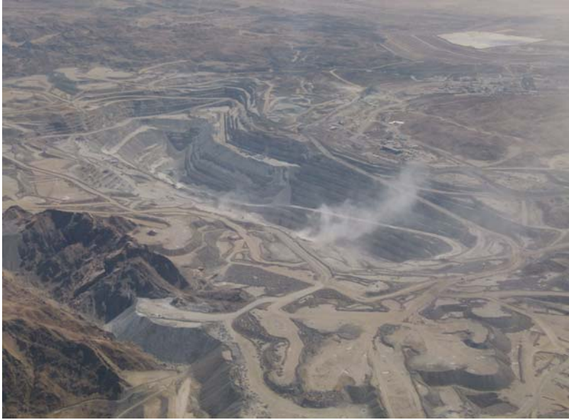
Abb. 20: Der „ mining footprint “ von Rössing mit seinem Tagebau und seinen Abraumhalden umfasst 2400 Hektar. Die Staubwolke deutet auf eine Sprengung uranhaltigen Gesteins hin.
