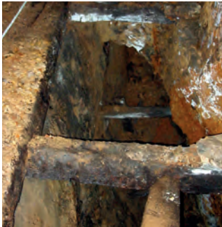
Abb. 8: Schachtauszimmerung in der Grube Steinbrunnen [Foto: Herbener (2012)] – Fig. 8: Shaft timbering in the pit „Steinbrunnen“ [Photo: Herbener (2012)].
