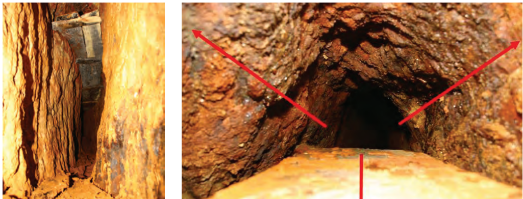
Abb. 16: Links: Wetterröschchen aus Holz an der Firste der spätmittelalterlichen Strecke im Besucherbergwerk Teufelsgrund/ Strecke Friedrich. Rechts: Hohlraum für den Rauchabzug Schlechtwetterabzug (Richtung der roten Pfeile) über der Wetterröschchen [Fotos: Herbener (2012)]. – Fig. 16: Left: wooden "Wetterröschchen" on the ridges wall of the late medieval visitors track Teufelsgrund /route Friedrich. Right: cavity for the flue/bad weather deduction (in the direction of the red arrows) above the "Wetterröschchen" [Photos: Herbener (2012)].
