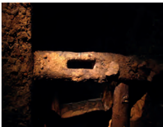
Abb. 9: Verstrebe Eichenholzbalken (Einstriche) mit rechteckigem Zapfloch für einen der Haspelträger [Foto: Herbener (2012)]. – Fig. 9: Braced oak beams (“Einstriche”) with rect-angular mortise for the reel carrier [Photo: Herbener (2012)].
