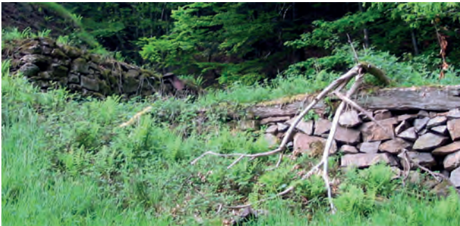
Abb. 7: Steinernes Fundament mit aufliegendem Schwellbalken des ehemaligen Huthauses im Grubenareal Steinbrunnen [Foto: Herbener (2012)].
