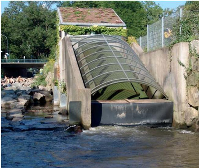
**Abb. 3** Eine Wasserkraftschnecke an der Dreisam in Freiburg. Wasserkraftschnecken funktionieren nach dem Prinzip der archimedischen Schraube. Die Installierung von drei Wasserkraftschnecken ähnlichen Bautyps an einem Emswehr war nicht genehmigungsfähig. (Foto: Nikolaus Geiler)
