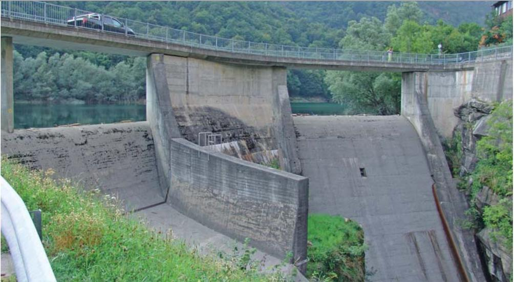
**Abb. 2.** Der weitaus größte Anteil der Stau- und Wehranlagen zur Wasserkraftnutzung wurde in Zeiten gebaut, in denen die Aufrechterhaltung der Durchwanderbarkeit noch keine Rolle gespielt hat. Der nachträgliche Einbau von Fischauf- und -abstiegen ist heute aus topographischen und finanziellen Gründen an vielen Standorten kaum noch möglich. Hier ein Extrembeispiel aus dem Calancatal in den Tessiner Alpen. (Foto: Nikolaus Geiler)
