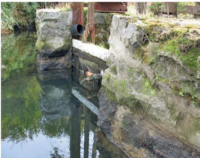
**Abb. 5.** Das gleiche Plastikrohr wie oben von Oberwasser aus gesehen. Die Öffnung des Rohres muss systembedingt in kurzer Zeit mit Falllaub und Geschwemmsel verstopfen. Zudem liegt die Öffnung des Rohres bei Niedrigwasser über dem Oberwasserspiegel. Eine ausreichende Mindestwasserdotierung – und damit eine „wesentliche ökologische Verbesserung“ - ist bei dieser „Rohrlösung“ nicht möglich.
