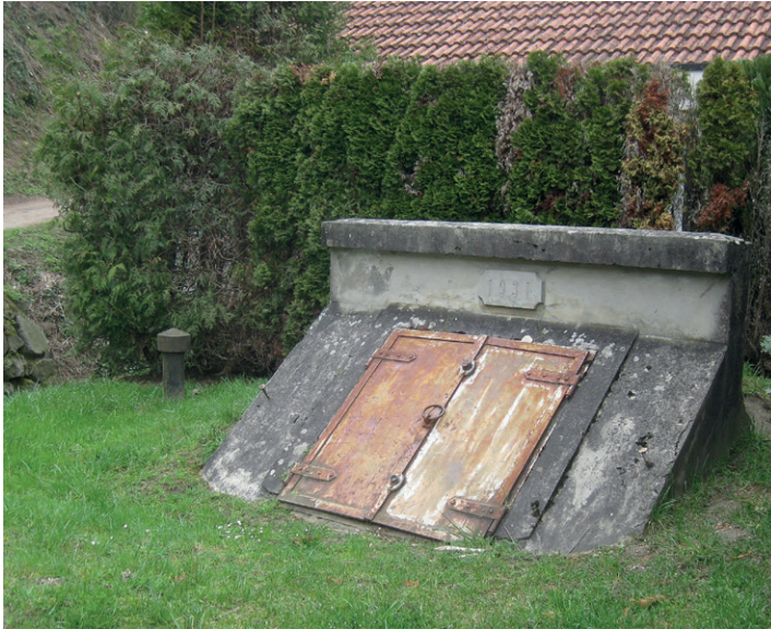
Abb. 33: Unterer Quellschacht mit Behälter in Amoltern. Foto: B.G. 20.12.2016. Beide Quellschächte tragen das Baujahr 1931. Sie liegen im Tal unmittelbar oberhalb der Ortschaft Amoltern. Fig. 33: The lower spring chamber with reservoir located in Amoltern.
