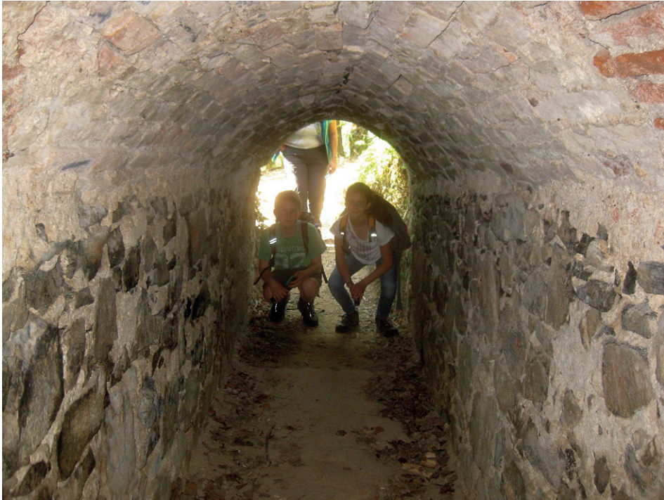
Abb. 39: Im gemauerten Erelochstollen durch den Lössrücken des Langeneckbergs liegt die Wasserleitung, die Quellwasser aus dem Riedtal ins Erletal zum Zweck der (früheren) Wasserversorgung von Endingen durchleitet. Foto: B.G., 09.04.2017. Fig. 39: The water pipeline within the Erelochstollen (tunnel) that leads through loess of the Langeneckberg.
