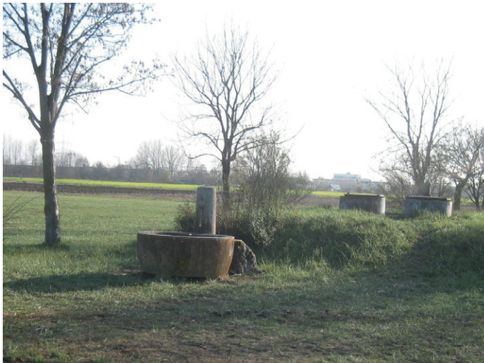
Abb. 19: Laufbrunnen neben dem Thermal-/Mineralwasserbrunnen Bahlingen. Foto: B.G., 17.11.2018.
