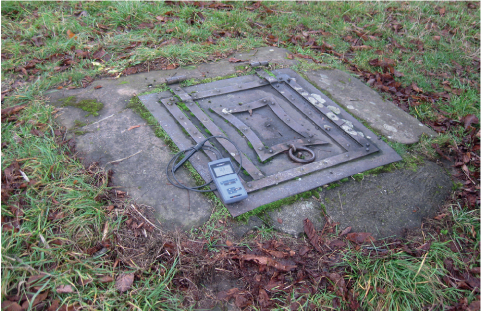
Abb. 36: Schachtdeckel des oberen Quellsammelschachts (QU 7812/25) im Quellgebiet Erletal, B.G., 05.12.2018. Fig. 36: Cover of the upper spring chamber in the Erletal spring area.
