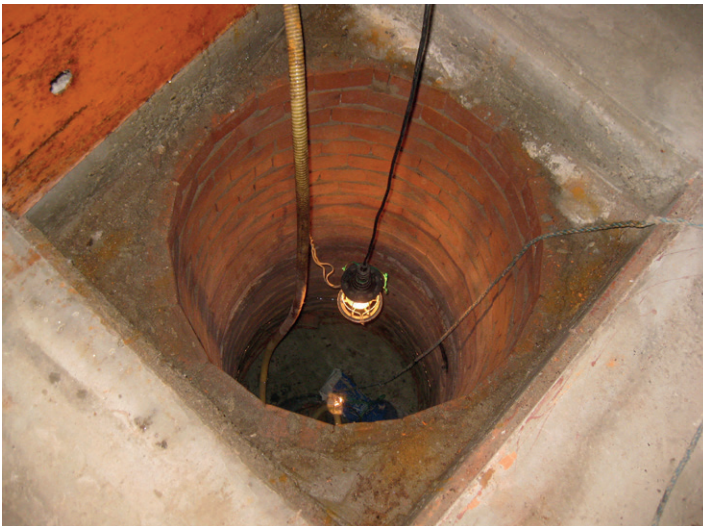
Abb. 49: Blick in den gemauerten Quellschacht der Schloss-Quelle. Foto: B.G., 31.03.2018.
