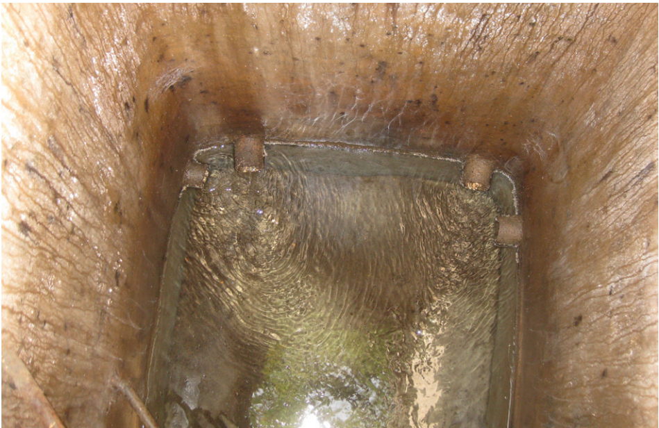
Abb. 37: Vier Einläufe (siehe Tabelle 14) im oberen Quellsammelschacht im Quellgebiet Erletal, B.G., 04.08.2016. Fig. 37: Four water inlets within the upper spring chamber in the Erletal spring area.
