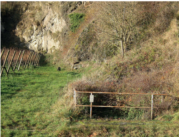
Abb. 80: Der in den Tephrit gehauene Behälter Bennfeld der Hochzone der früheren Wasserversorgung von Achkarren (Bildmitte am Fuß des Steilhangs); aufgenommen von der Kreisstraße K 4927. Foto: B.G., 25.11.2017.
