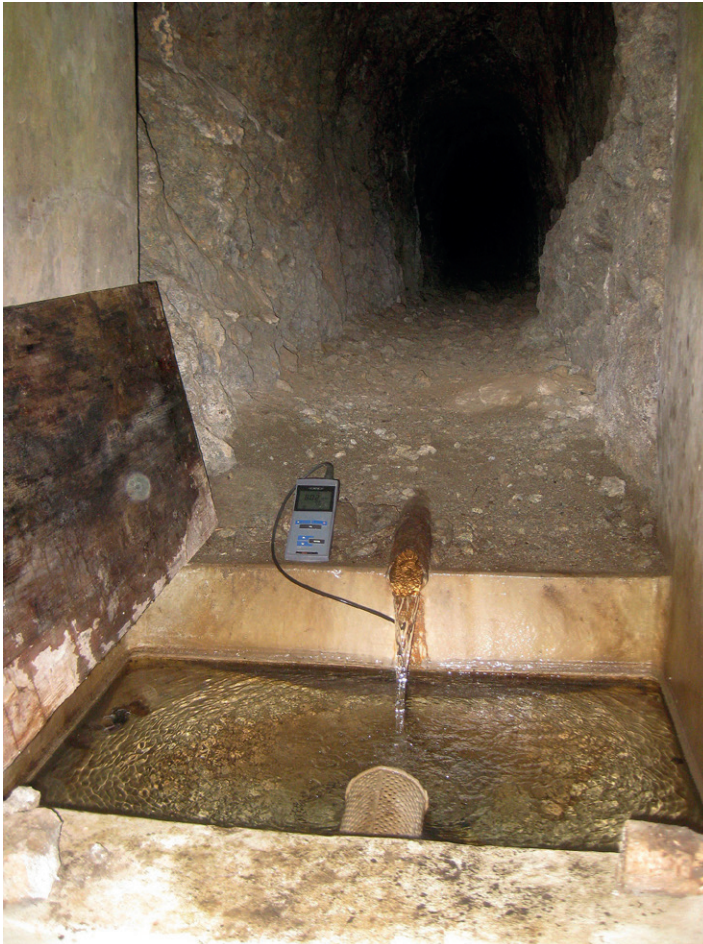
Abb. 81: Stollenportal Süd; Wasserauslauf der auf Gemarkung Bickensohl im Gewann Obermatt gefassten Quellen der früheren Wasserversorgung von Achkarren. Der Stollen wurde eigens für die Durchleitung des Quellwassers von Bickensohl nach Achkarren angelegt. Im Stollen steht die Tephrit-Tuffbrekzie an. Foto: B.G., 02.04.2019. Fig. 81: Portal area South; outlet of spring water tapped in the bounds of Bickensohl. The springs were formerly connected to the water supply scheme of Achkarren.
