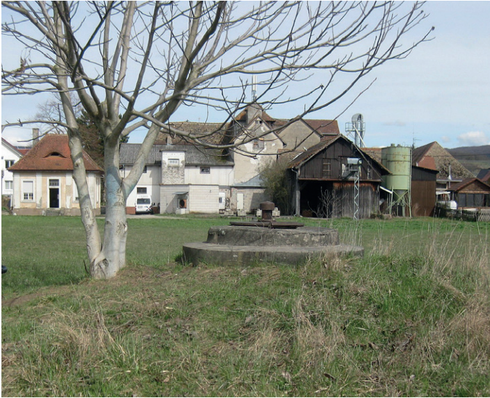
Abb. 90: Der Tiefbrunnen Burkheim aus dem Jahr 1912 mit dem ehemaligen Pumpwerk (links im Hintergrund) liegt am südlichen Ortsrand. Foto: B.G., 31.03.2018.
