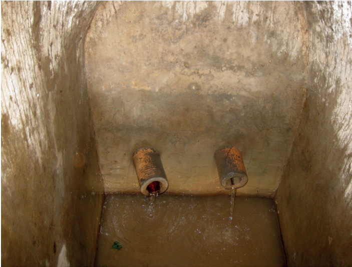
Abb. 93: Einlauf der beiden Lochdobel-Quellen im Quellschacht. Die Schüttung ist gering, das Quellwasser ist trübe. Foto: B.G., 21.03.2017.
