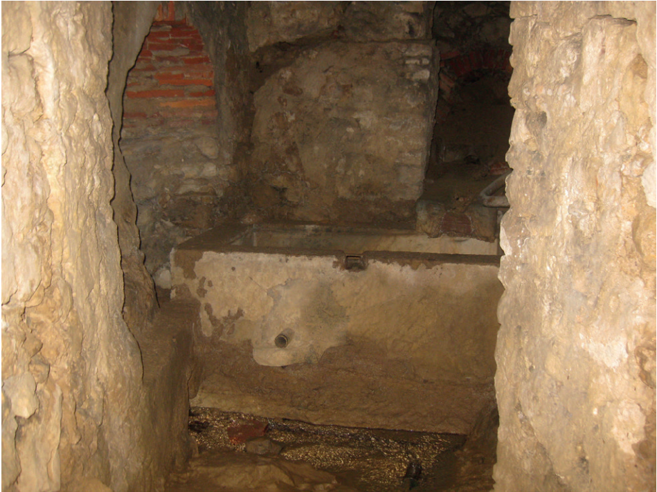
Abb. 26: Die Fassung der Quelle des Angelsportvereins. Der Quellaustritt liegt hinter einer großen ausgemauerten Höhle im Löss. Foto: B.G., 19.04.2019. Fig. 26: Tapping of the spring used by the local fishing club. The water emerges behind a big cave.
