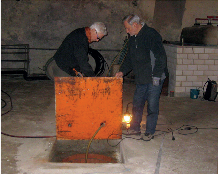
Abb. 48: Die Schloss-Quelle entspringt im Keller des Schlosses der ehemaligen Probstei Tennenbach. Der Quellschacht ist geöffnet. Foto: B.G., 21.03.2018.
