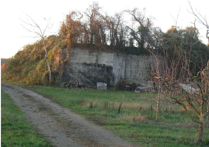
Abb. 75: Der verbunkerte Tiefbrunnen, aufgenommen von Osten. Dieser sollte einen verbunkerten Wasserbehälter für die Wasserversorgung einer Batteriestellung speisen. Die Bauwerke wurden zwar errichtet, das Wasserversorgungsprojekt aber nicht mehr umgesetzt. Foto: B.G., 31.03.2018.
