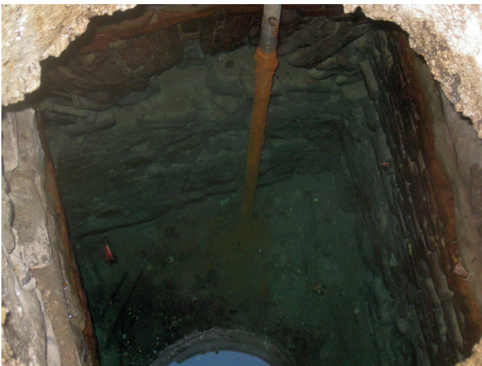
Abb. 91: Quellfassung am Brünneleuck. Das Quellwasser tritt am Boden des rechteckigen Schachts aus. Foto: B.G., 28.12.2016.
