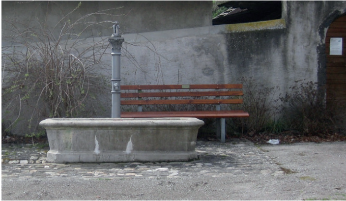
Abb. 92: Laufbrunnen am Brünneleuck. Der Quellschacht liegt unmittelbar hinter dem Brunnen. Foto: B.G., 30.03.2018.
