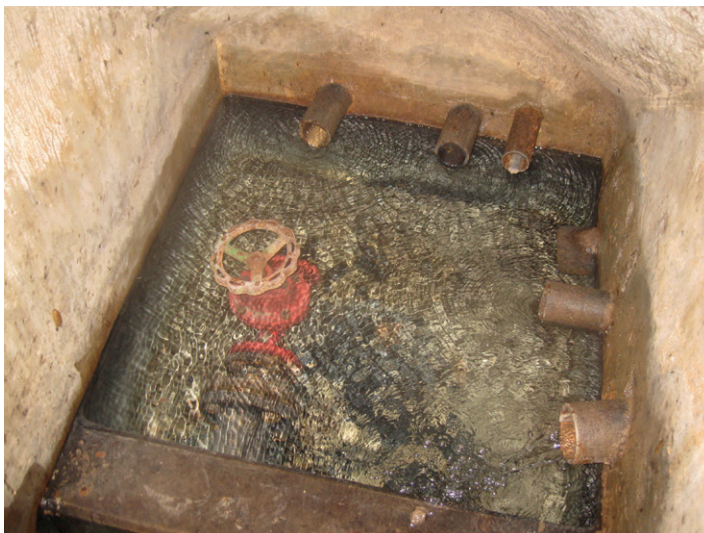
Abb. 44: Die sechs Einläufe im unteren Quellschacht im Tennenbachtal, siehe oben. B. G., 13.07.2017. Fig. 44: Six water inlets exist within the lower chamber located in the Tennenbachtal.
