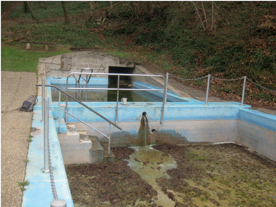
Abb. 15: Die Bad-Quellen 1 und 2 speisen das Tretbecken der Gemeinde Oberbergen von 1926. Der flache Stollen der Bad-Quelle 1 befindet sich an der Öffnung hinten rechts und der Einlauf ins Tretbecken in der Bildmitte. Foto: B.G., 18.03.2019. Fig. 15: The Bad Quellen 1 and 2 are feeding the Tretbecken (built in 1926) in Oberbergen.
