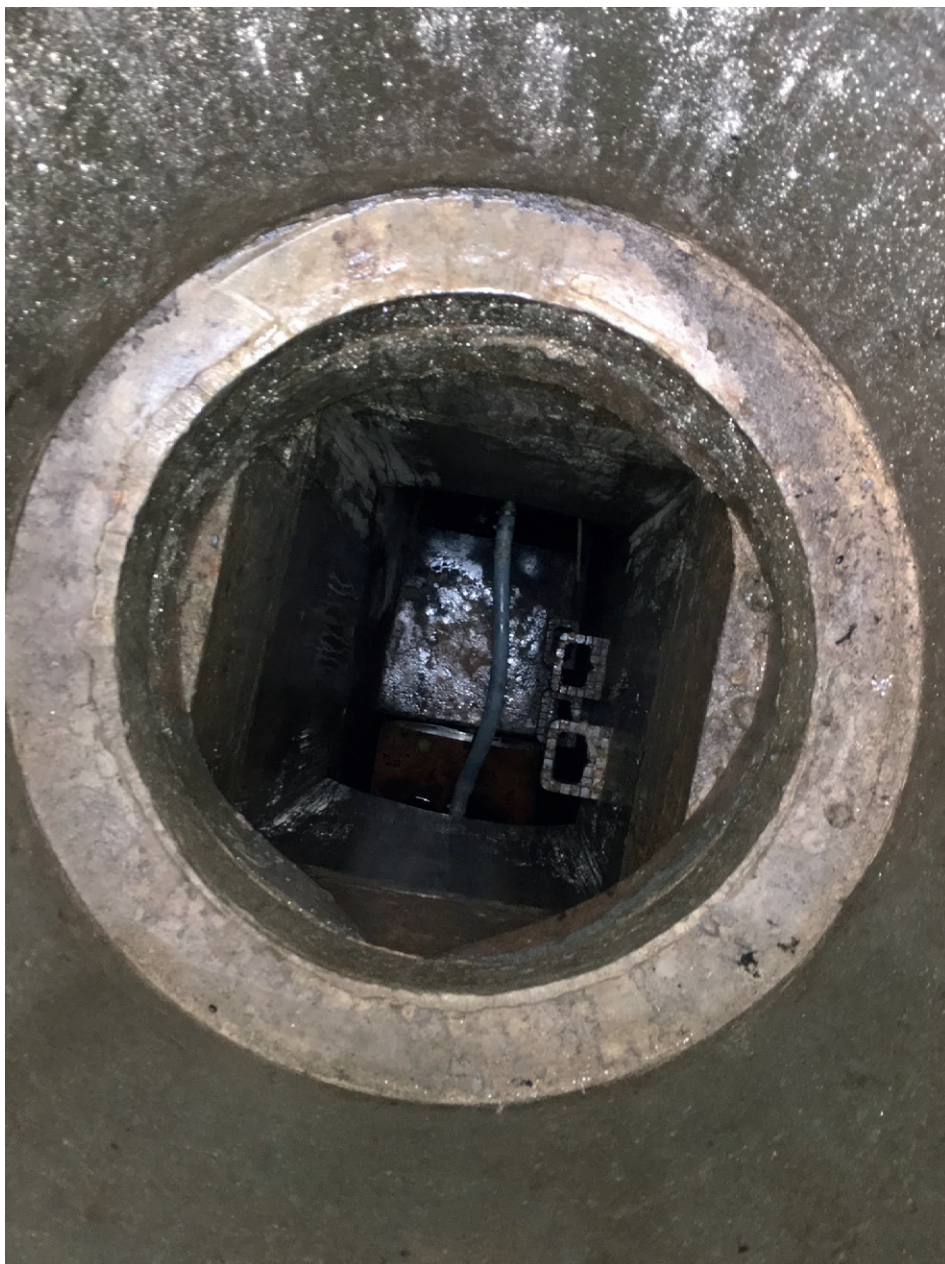
Abb. 20: Quellschacht der Brettel-Quellen. Der Quellschacht wurde um mehrere Meter erhöht, um das neue Geländeneiveau nach der Flurbereinigung zu erreichen. Foto: B.G., 02.02.2017. Fig. 20: Spring chamber of the Brettel-Quellen.
