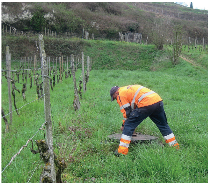
Abb. 57: Der Quellschacht der Zwehrenbach-Quelle liegt mitten im Rebgelände. Foto: B.G., 08.04.2016.
