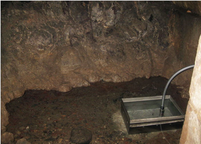
Abb. 11: Fassung der Haubrunnen-Quelle. Das im Tephrit austretende Quellwasser entspringt im offenen Schacht des Rebhäuschens und wird bei Bedarf nach oben gepumpt. Foto: B.G., 19.10.2017.
