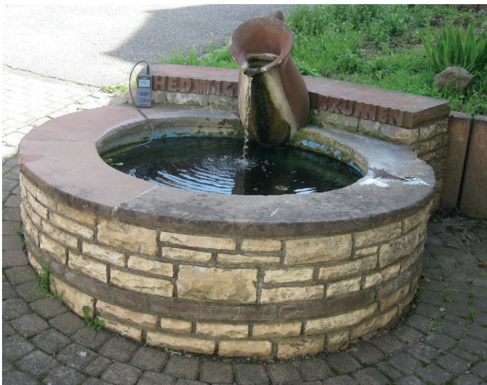
Abb. 86: Laufbrunnen Hedwigbrunnen. Die Quellfassung liegt unmittelbar in der Nähe des Laufbrunnens. Foto: B.G., 10.04.2016.
