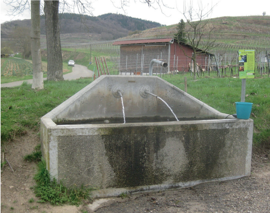
Abb. 27: Der Weingartenbrunnen wird gespeist von den Weingarten-Quellen 1 und 2. Er verfügt über eine Wasserzapfstelle. Foto: B.G., 18.03.2017. Fig. 27: The Weingarten-Quellen 1 and 2 are supplying the Weingartenbrunnen. The well has a water tapping point.
