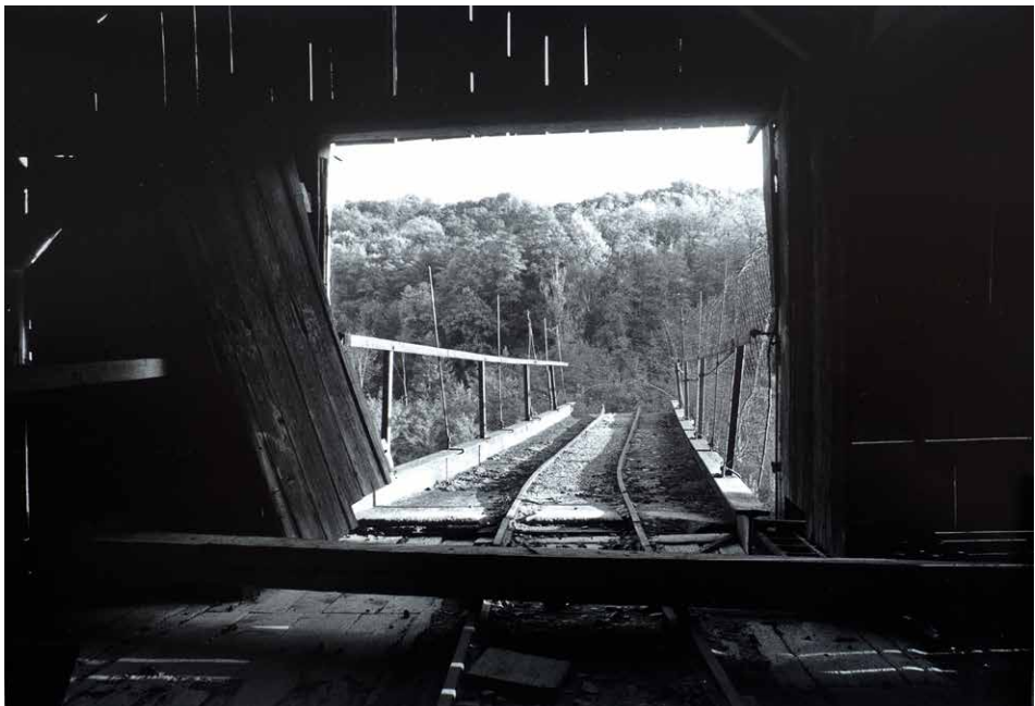
Abb. 100: Ein Industriedenkmal - dem Verfall preisgegeben: Blick vom alten Brecherwerk über die Hochbrücke in Richtung Kirchberg. Original F. Wilhelm / Reprofoto Eike Marzi. Fig. 100: An industrial monument - abandoned to decay: View from the old crusher plant over the ridge in direction of the Kirchberg. Original F. Wilhelm / repro photo Eike Marzi.
