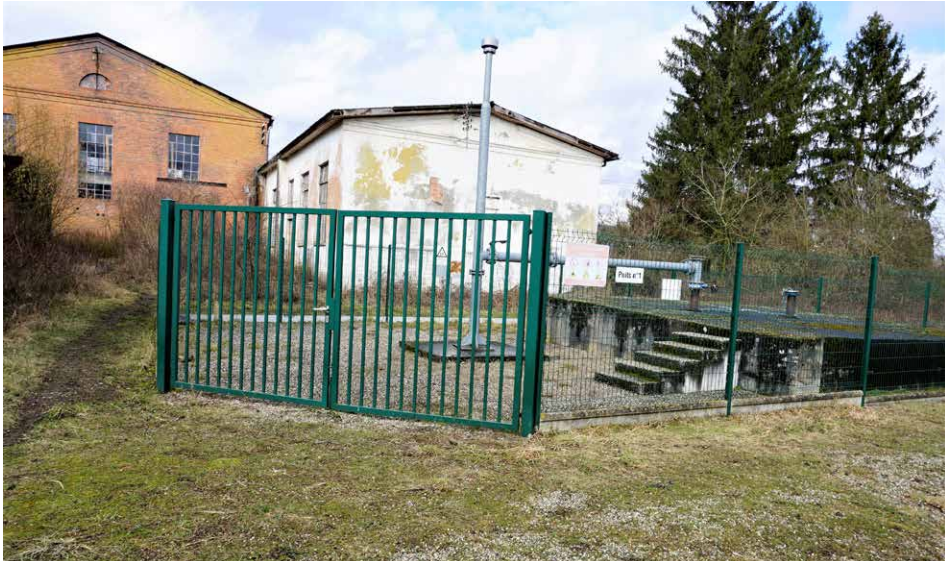
Abb. 20: Blick auf die Abdeckung des ehemaligen Schacht I (Puits I) mit Entgasungsrohr und dem ehemaligen Fördermaschinenhaus im Hintergrund. Foto: M. Hauck. Fig. 20: View of the covered former shaft I (Puits I) with the degassing pipe and the former hoisting machine house in the background. Photo: M. Hauck.
