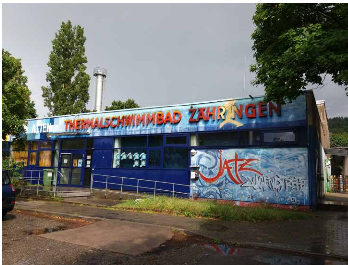
Abb. 44: Ehemaliges Thermalschwimmbad Zähringen, heute Schulkindergarten für Körperbehinderte der AWO Freiburg und Jugendtreff, Foto: B.G., 07.06.2022.
