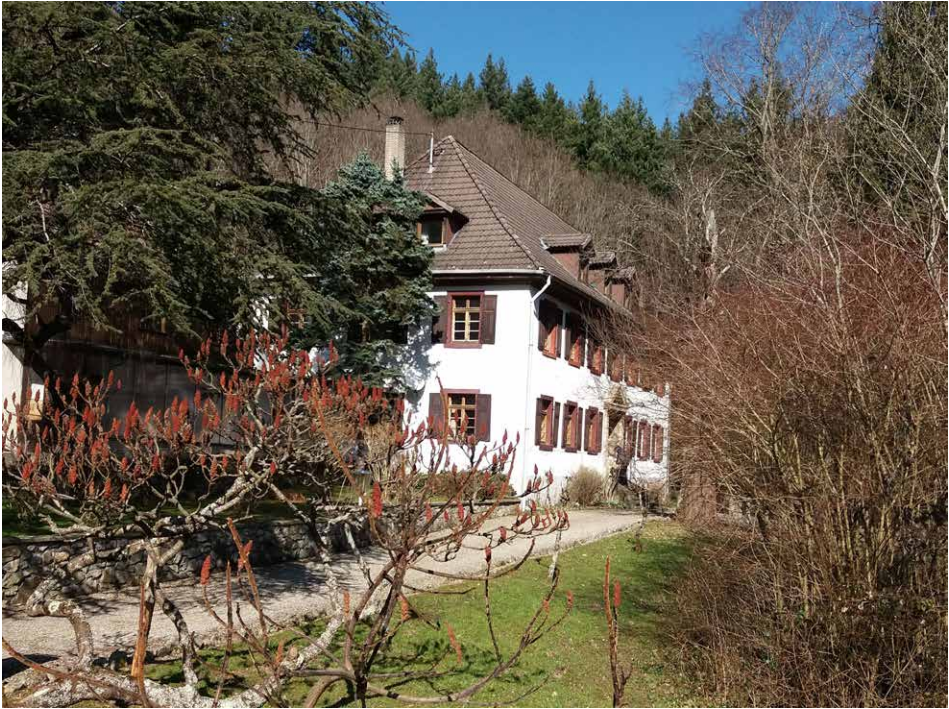
Abb. 40: Das frühere Wirtschaftsgebäude des Kybbades von 1839 ist heute in Privatbesitz, Foto: B.G., 01.03.2022. Fig. 40: The former building of the so-called Kybbad spa from 1839 is today privately owned.
