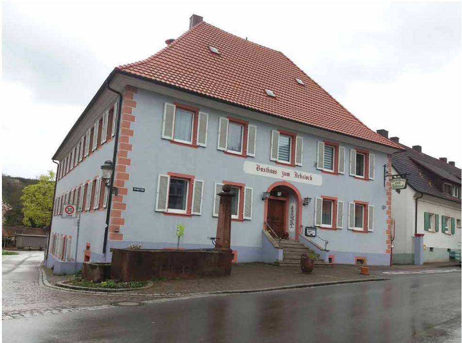
Abb. 4: Ehemaliges Gasthaus Rebstock mit Laufbrunnen vor dem Gebäude an der Bergstraße. Die Bäder lagen im Kellergeschoss; Foto: B.G., 30.03.2022. Fig. 4: Former inn „Rebstock“ with standpipe in front of the building on the street Bergstrasse. The bathrooms were in the basement.
