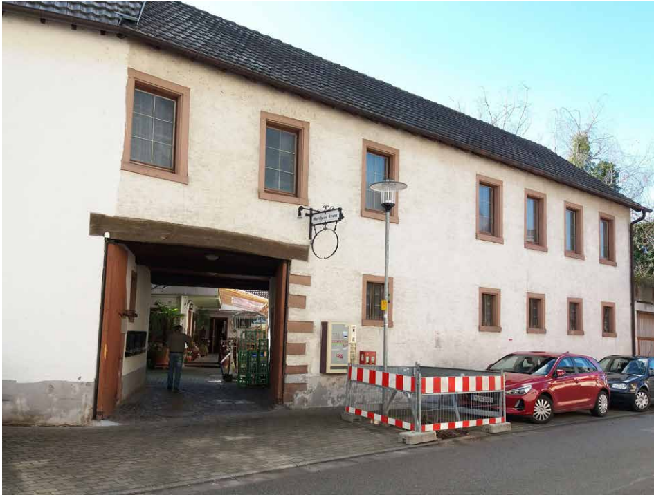
Abb. 34: Das frühere Bad im Hintergebäude des Gasthauses Krone; Foto: B.G., 23.02.2022. Fig. 34: The former spa in the rear building of the restaurant „Krone“.
