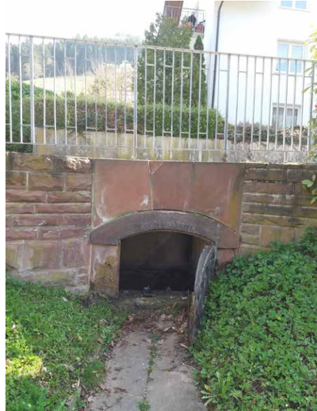
Abb. 39: Brunnenstube der Schwefelquelle Suggental; diese liegt unmittelbar unter der Trasse der Talstraße; Foto: B. G., 28.03.2022. Fig. 39: Source house of the sulphur spring Suggental; this lies directly under the route of the Talstrasse.
