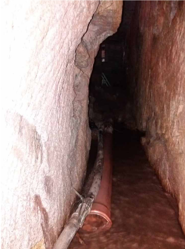
Abb. 13: Stollen mit Blick zum Stollenausgang. Das im Stollen anfallende Grundwasser fließt in das PVC-Rohr und wird in den Eisenbach geleitet. Foto: B.G., 26.04.2022.
