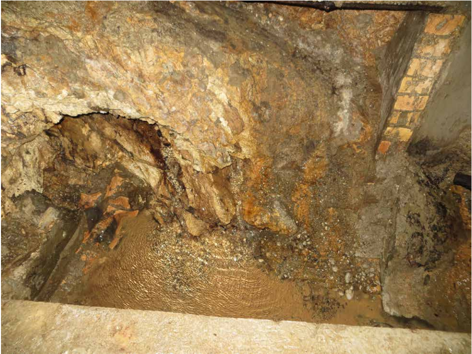
Abb. 26: Quellaustritt aus dem Kristallinen Grundgebirge im Quellschacht der Bad-Quelle Sulzburg, Foto: Martin Lindenlaub, 03.02.2017. Fig. 26: Spring discharge from crystalline basement in the spring shaft of the Bad-Spring Sulzburg.
