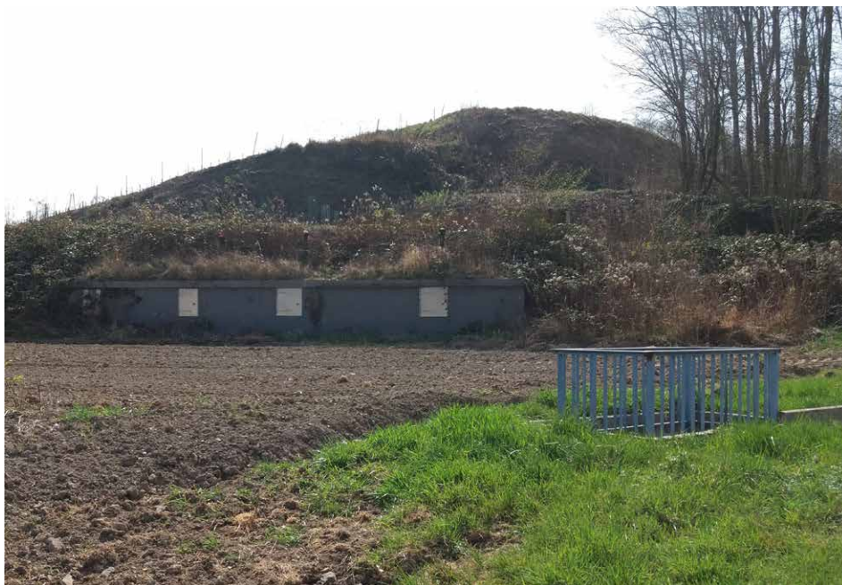
Abb. 30: Wasserbehälter der ehem. Firma Silberbrunnen (in den Berghang gebaut); rechts der mit Geländer gesicherte Schacht, wo sich der Quellwasserüberlauf befindet, Foto: B.G., 28.03.2022. Fig. 30: Water reservoir of the former company Silberbrunnen (built into the hillside). On the right, the shaft secured with a railing, where the spring water inlet is located.
