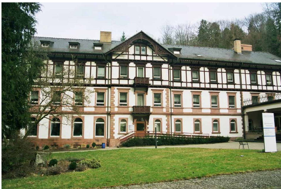
Abb. 32: Ehemaliges Kurhaus Bad Kirnhalden, Foto: W. Käß., 09.03.2008. Fig. 32: Former spa house Bad Kirnhalden.
