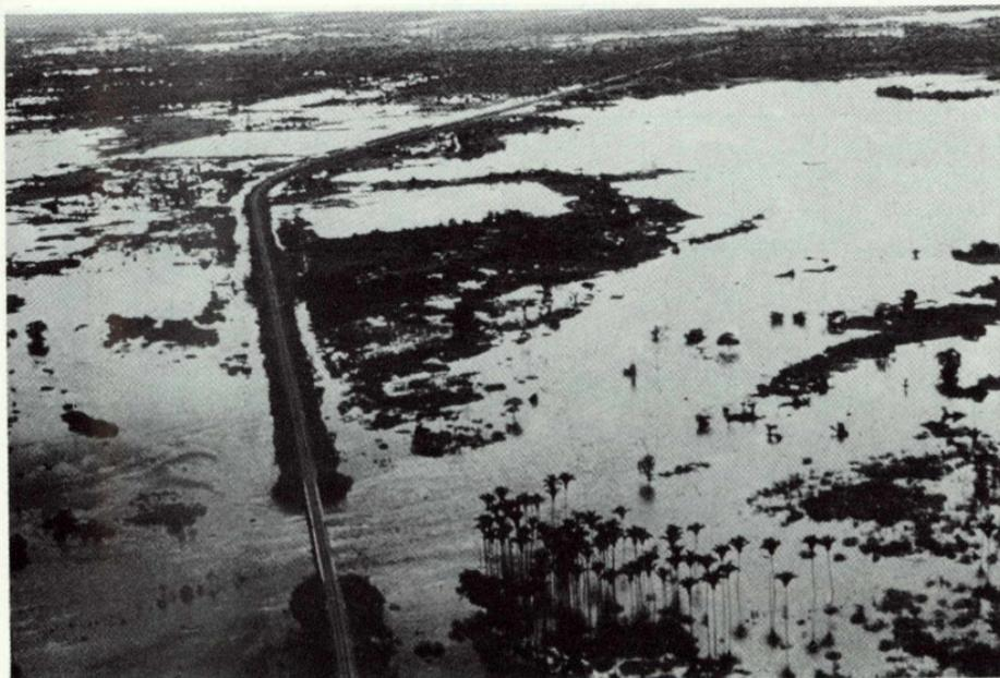
Abb. 2.15: Bei dem Bau der 890 km langen Eisenbahnlinie von der Küste bei São Luis in die Serra dos Carajás zum Abtransport der Erze mußten auch breite Überflutungsebenen überbrückt werden (km 141, Foto: *Companhia Vale do Doce*).
