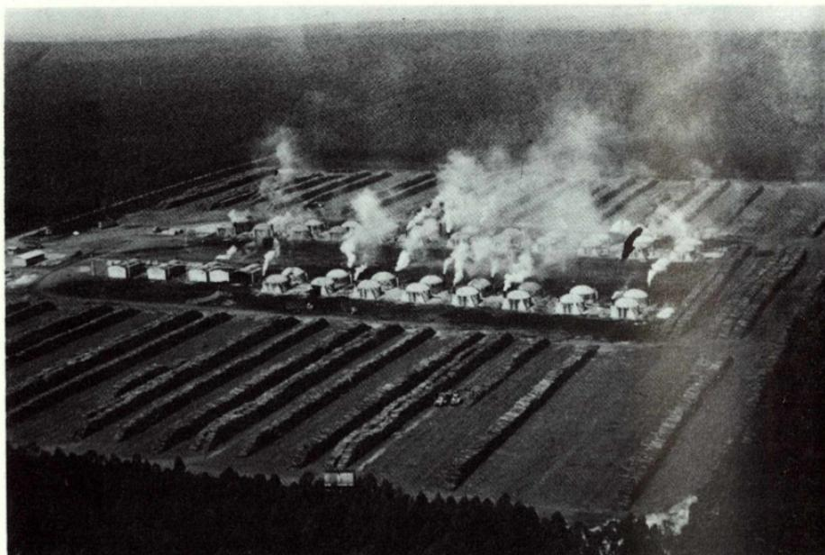
Abb. 6.4: Die Verarbeitung von *Eucalyptus* in einer Holzkohle-Fabrikationsanlage, errichtet inmitten einer riesigen Holzplantage. Noch wird hier arbeitsintensiv der Energielieferant für die Stahlindustrie erzeugt. Moderne Retortenverfahren sind aber bereits in der Planung.
