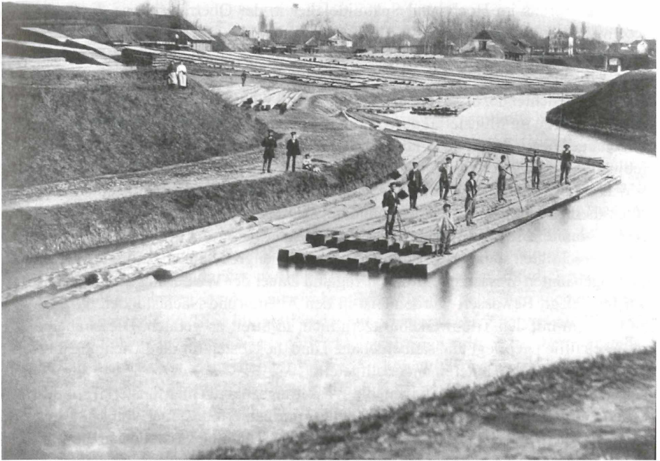
Abb. 4: Der Neumagen-Möhlin-Flößereikanal. Diese Aufnahme entstand ca. 1868. Damals wurde in kleinerem Umfang die Flößerei wieder aufgenommen (Quelle: GEIGES 1989:146).
