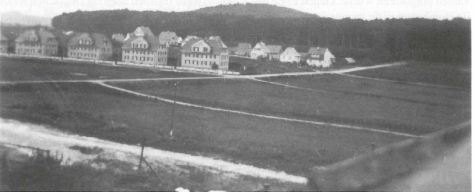
Abb. 4: Blick vom Fürstenberg über das westliche Haidelmoos zu den Mehrfamilienhäusern entlang des Wollgrasweges im Jahr 1937. Dahinter ist die Bebauung entlang des Mondrauteweges zu sehen. Im Mittelgrund der noch unbebaute Schleyerweg. (Quelle: Archiv W. Geyer, Konstanz).
