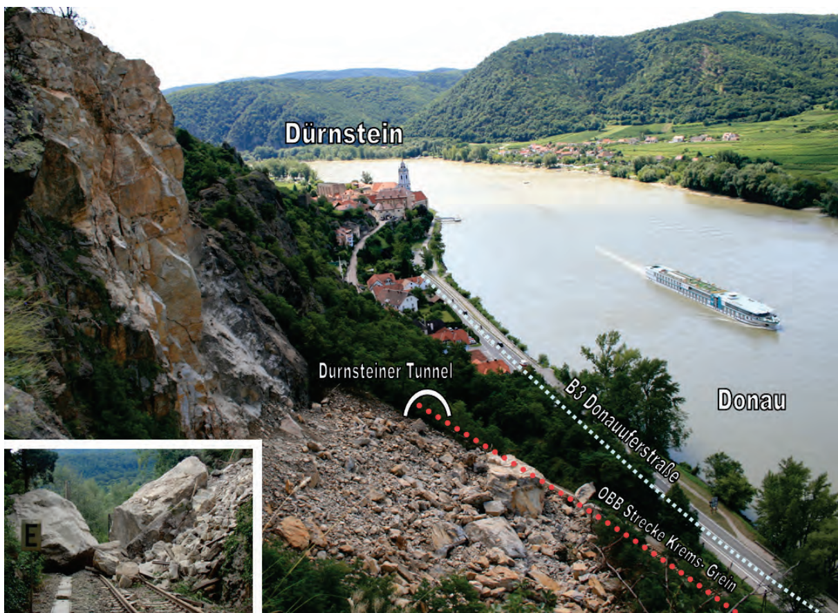
Abb. 1: Felssturz Dürnstein/ Wachau, Niederösterreich
