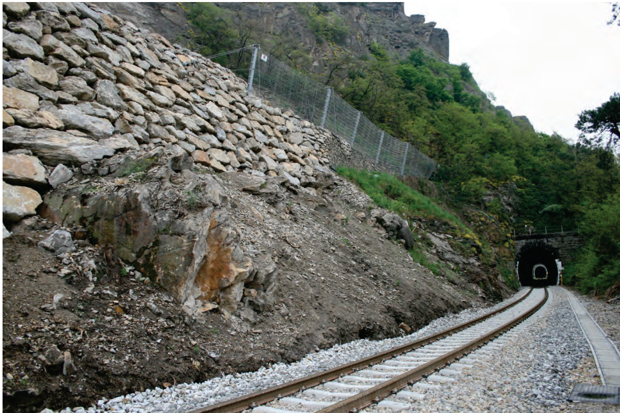
Abb. 3: Wiederinbetriebnahme der Bahnstrecke
