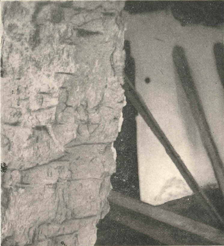
Aufn. von Dr. Elfriede Hermann. Abb. 1: Lehm-mauer, mit Wacholderzweigen verstärkt, im Abbruch. Kleinbachtal Nr. 41.
