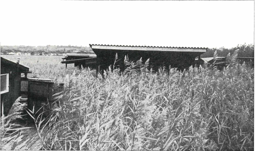
Abb. 7 Freizeitwohnsitztyp 5 — Pfahlbausiedlung Weiden am See. Die Wohnobjekte weisen überwiegend Badehüttencharakter auf und befinden sich teilweise in schlechtem baulichen Zustand.
