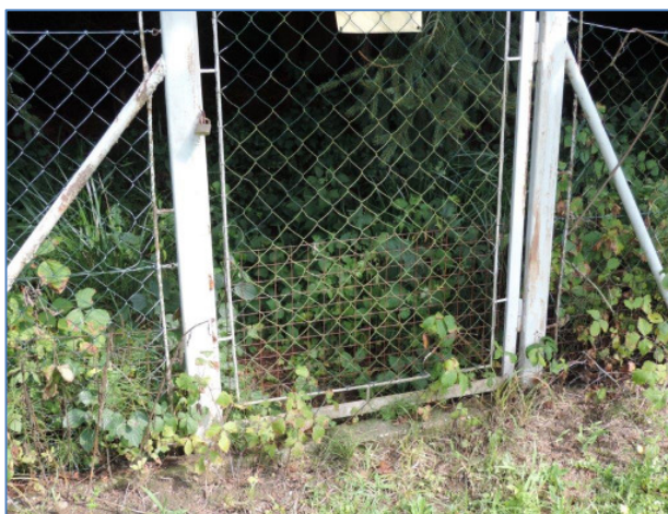
Zwei Beispiele von otterdichtem Zaun-Bodenschluss im Bereich von Eingangstoren
