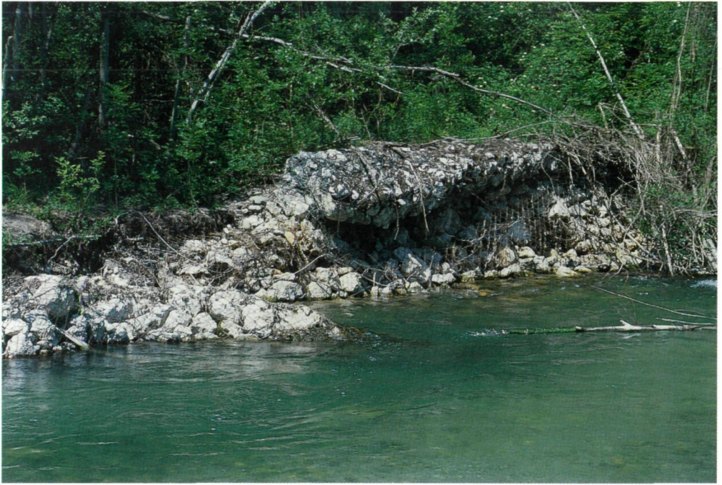
Abb. 14: Unterspülte Drahtkofferbuhne. Foto: G. Egger
