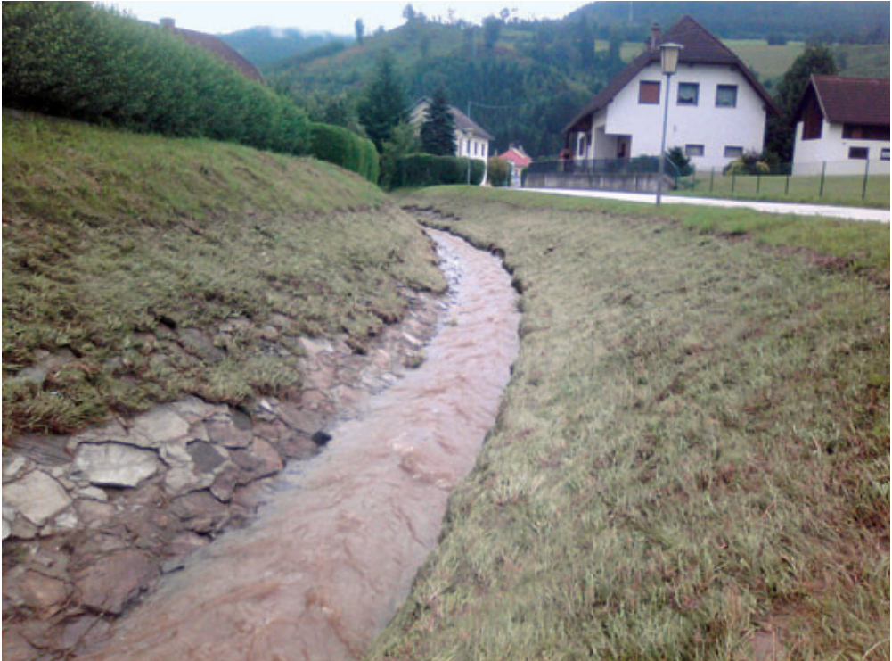
Abb. 10: Spuren des HQ_{50} - Ereignisses am Langwiesenbach innerhalb des regu- lierten Bereiches. Foto: H. Korenjak
