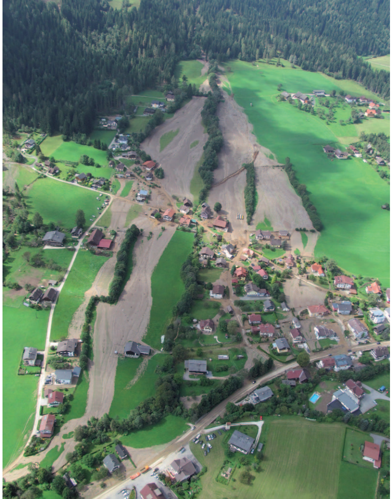
Abb. 15: Hochwasser und Murenabgang in Afritz, Ortsteil Kraa, mit verheerenden Schäden. Foto: Land Kärnten
