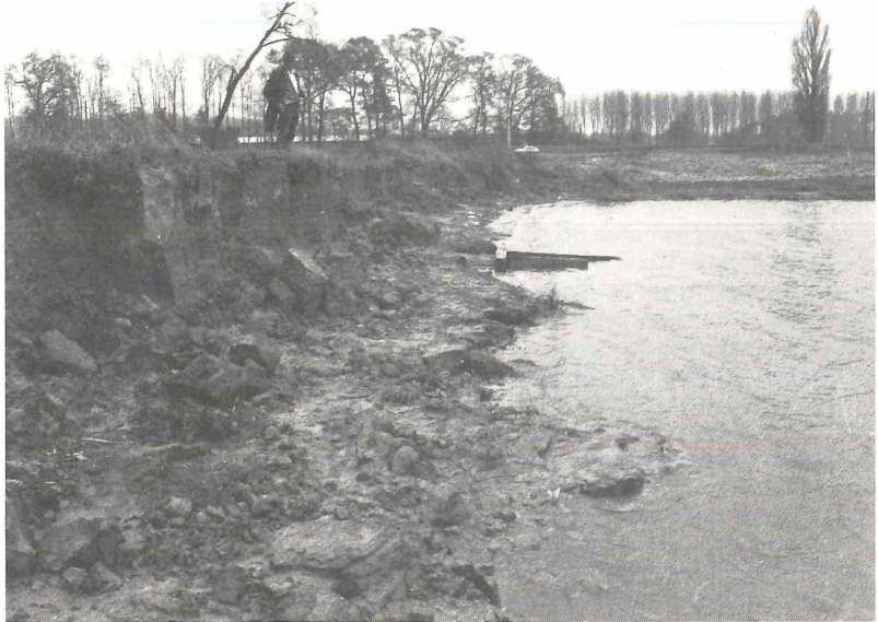
Abbildung 10. Rasche Rückverlegung einer Lößlehmaböschung mit sehr flacher Erosionsplattform (< 1:10). Kiesgrube „Im Binsfeld“ (Speyer).
