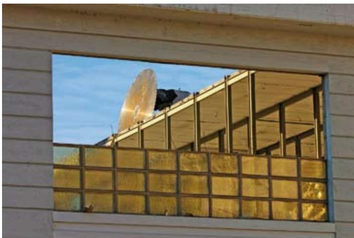
Abbildung 19. Mit überdimensionalen Trennscheiben wird der Stahlbeton des Nachkriegsbau für den Abtransport fein säuberlich zerlegt.
