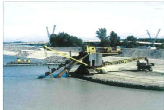
**Abb. 11:** Aushubarbeiten (Eimerkettenbagger, Großraummuldenkippen). Foto: H. Antos
