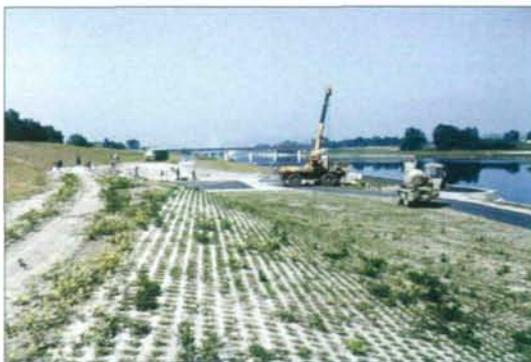
**Abb. 7:** Böschungssicherung mit Beton-Gras-Steinen.
