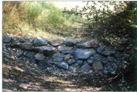
**Abb. 17:** Ein aus Blocksteinen und Schotter errichteter Damm sperrt den Verbindungsgraben zwischen Sektor E und Hauptwasserkörper. Foto: H. Teuffl
