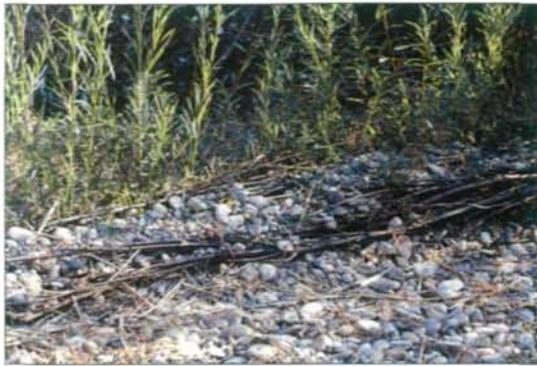
**Abb. 16:** Nach einiger Zeit treiben die Weiden der Verschiebungen aus und festigen die Konstruktion. Foto: H. Teuffl
