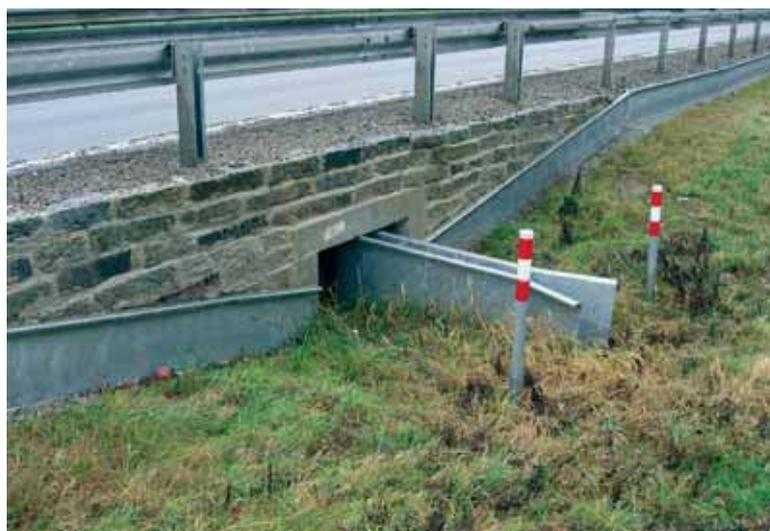
**Abb. 8:** Die kürzlich fertig gestellte Tunnel-Leit-Anlage in Nettingsdorf bei Ansfelden als Beispiel für eine dauerhafte Amphibienschutzanlage. Die Tunneln sind aus Beton, das Leitsystem aus Metall. In die Tunnel ragende Bleche lenken die Lurche zu den Eingängen. Foto: W. Weißmair.
