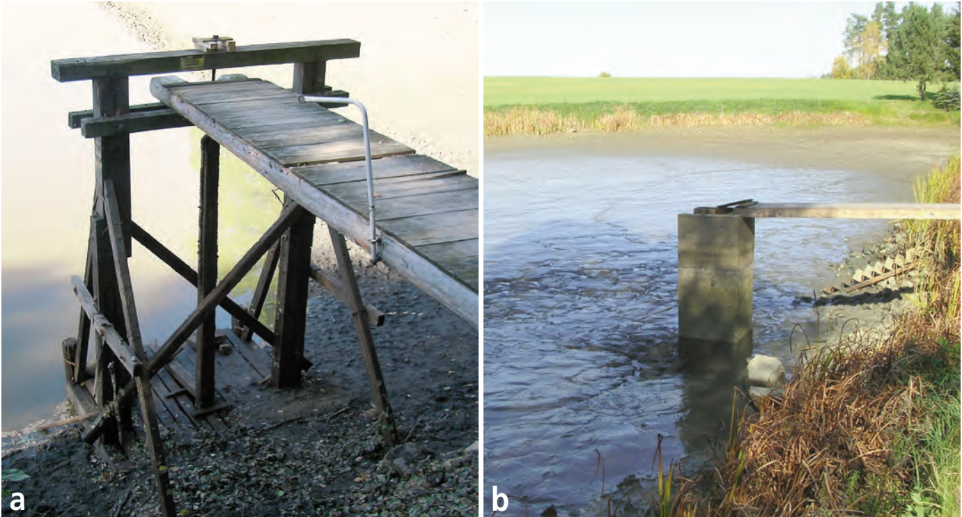
Abb. 6: a: Zapfen: Ablassvorrichtung, die im Prinzip wie der Stoppel einer Badewanne funktioniert. Foto: Christian Bauer. b: Mönch: Ablassvorrichtung mit Staubrettern, die ein Ablassen des Grund- oder des Oberflächenwassers sowie eine einfache Regulierung des Wasserstandes ermöglicht. Foto: Bundesamt für Wasserwirtschaft.
