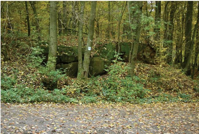
**Abb. 28:** Oft ragen von übererdeten Bunkern (hier B 411) nur wenige Betonreste aus dem Boden. In schattiger Lage siedeln sich an den austretenden Moniereisen auch Flechten an.
