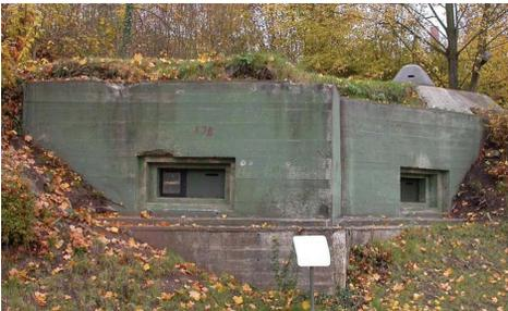
**Abb. 22:** Intakte, nicht gesprengte Bunker wie B 116 in Mettlach tragen oft noch den Originalanstrich und sind von Flechten nur schwer zu besiedeln.
