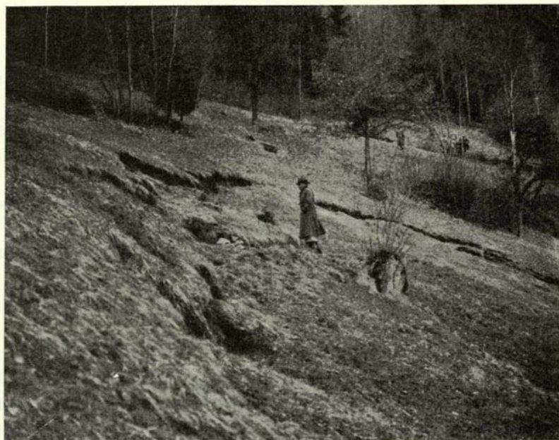
Fig. 22. Glissement de terrain de Mermier. Fissures d'arrachement transversales et hémicycliques à l'amont de la route de Pont-de-Fillings à Boège. 28 II 1936.
