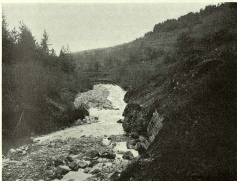
Fig. 23. Glissement de terrain de Mermier. Le front de la coulée et la Menoge. On mesure les effets de la poussée à la déformation du mur de soutènement dont la première partie est presque intacte. La seconde est propulsée à 3 mètres en avant de la première et la suivante est complètement emportée. Le cours d'eau est rétréci sur le front de la coulée. Son lit est encombré de blocs provenant du délavage de la moraine au fur et à mesure de sa progression. 28 II 1936.
