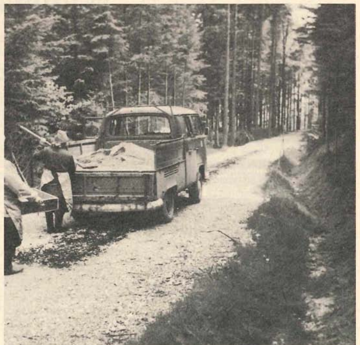
Abdecken und Beschweren der Torfmüllschicht gegen Verwehung und Abschwemmung mit Sand 0/3. Foto aufgenommen im Mai 1978.
