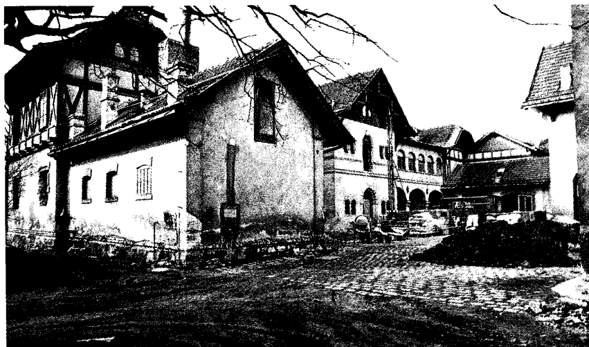
Das künftige Forschungsinstitut während des Umbaus
