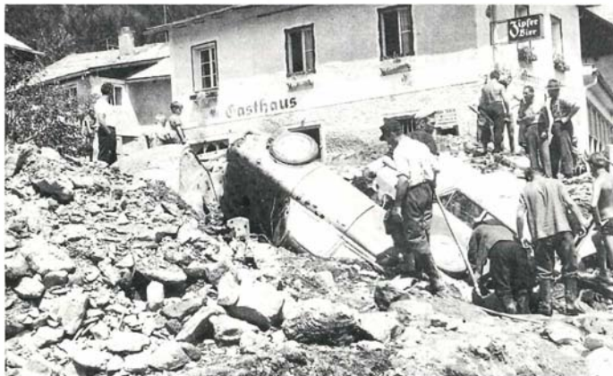
In Unkenntnis der Naturgefahren baut der Mensch bis nahe an die Wildbäche heran. Die so gebauten Gefahrenräume werden bei Hochwasserereignissen vom Wildbach zurückerobert. Einöbbach; Zell a. See, Salzburg.
