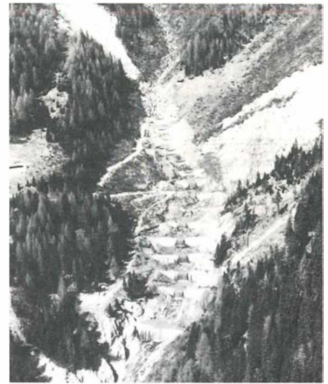
Im Oberlauf müssen umfangreiche Verbauungen die Heilung der durch die Mure gerissenen Geländewunden herbeiführen. Wollinitzbach; Gde. Flattach, Kärnten.
