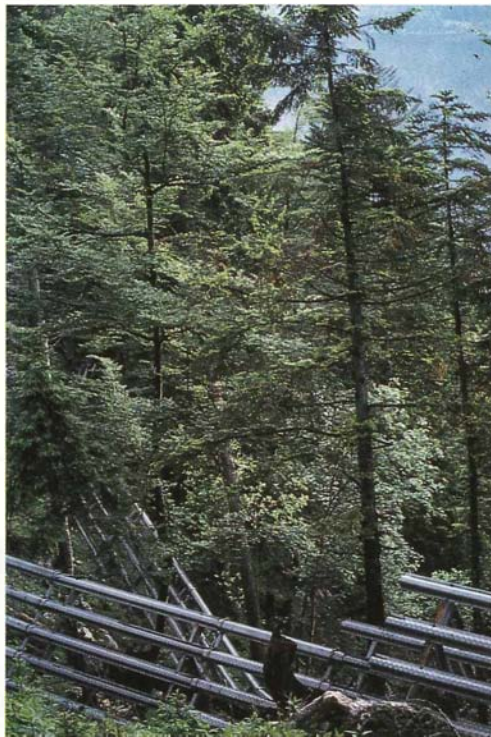
Technische Anlagen können langfristig die Funktion der Schutzwälder nicht ersetzen.
