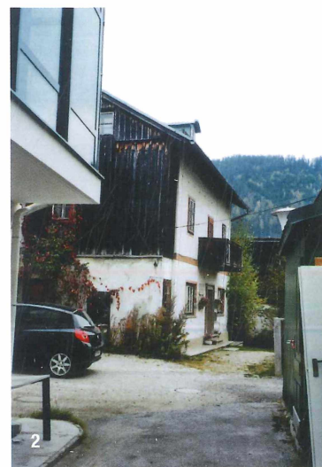
Abb. 2: Die Probiertube in der Griesgasse 127. Unter dem Dach sind kleine Lüftungslöcher erkennbar, die auf die Lage einer Probiertube darunter hinweisen. Im Vordergrund links ein Stück der stark veränderten Schaidstuben/Probiertuben Keusche . Situation 2010. Foto: A. Weiß, Wien.
