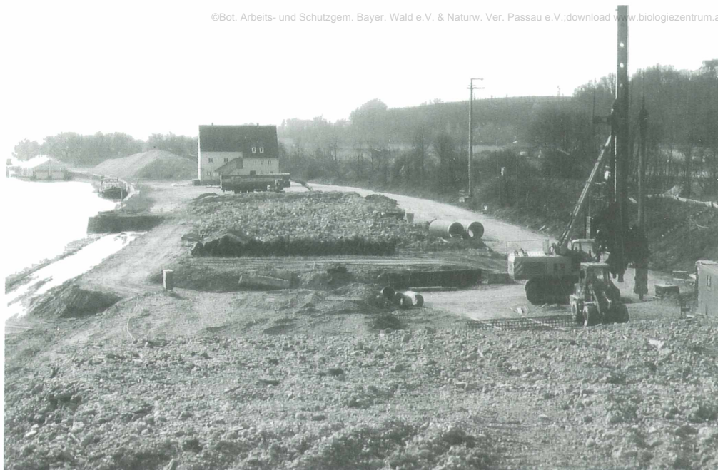
Abb. 3: Zerstörung weit vorangeschritten - Hafengelände von Osten im April 1996
