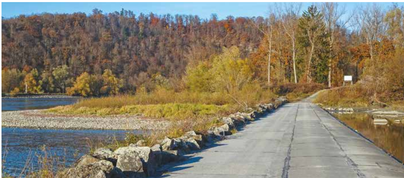
Abb. 28: Der Fahrddamm zur Soldatenau ist stromaufwärts mit aneinandergereihten Granitblöcken gesichert. Auf diesen haben sich Flechten angesiedelt, die Nährstoffeinträge und Kalkeinfluss belegen.
