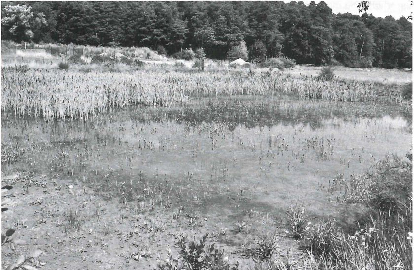
Abb. 8: Regenrückhaltebecken bei Mackenbach (FO 6). 15.07.2008. Foto: U. LINGENFELDER.
