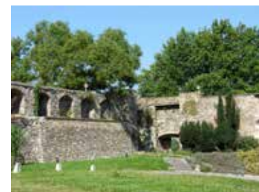
ABB. 40: Linz, Schloss, Ruinen des Wall- gebäudes, um 1616–1618
