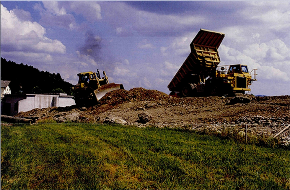
Abb. 18: Die Errichtung des Dammes in Teichstätt, Foto: GEWÄSSERBEZIRK BRAUNAU.
