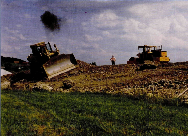
Abb. 13: Beginn der Bauarbeiten, Foto: GEWÄSSERBEZIRK BRAUNAU.
