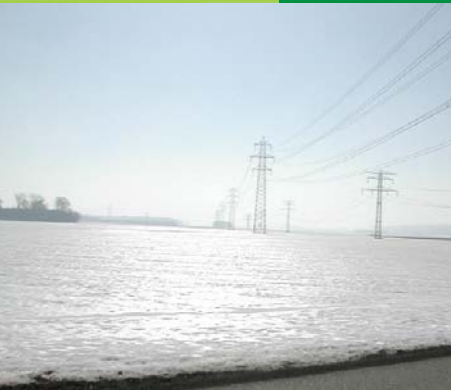
„Strom-Autobahn“ über die Felder
