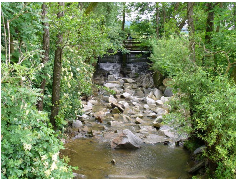
Abb. 8: Wehr/Kleinkraftwerk am St. Veiter Bach bei Dötting (Foto: A. Lichtenecker)
