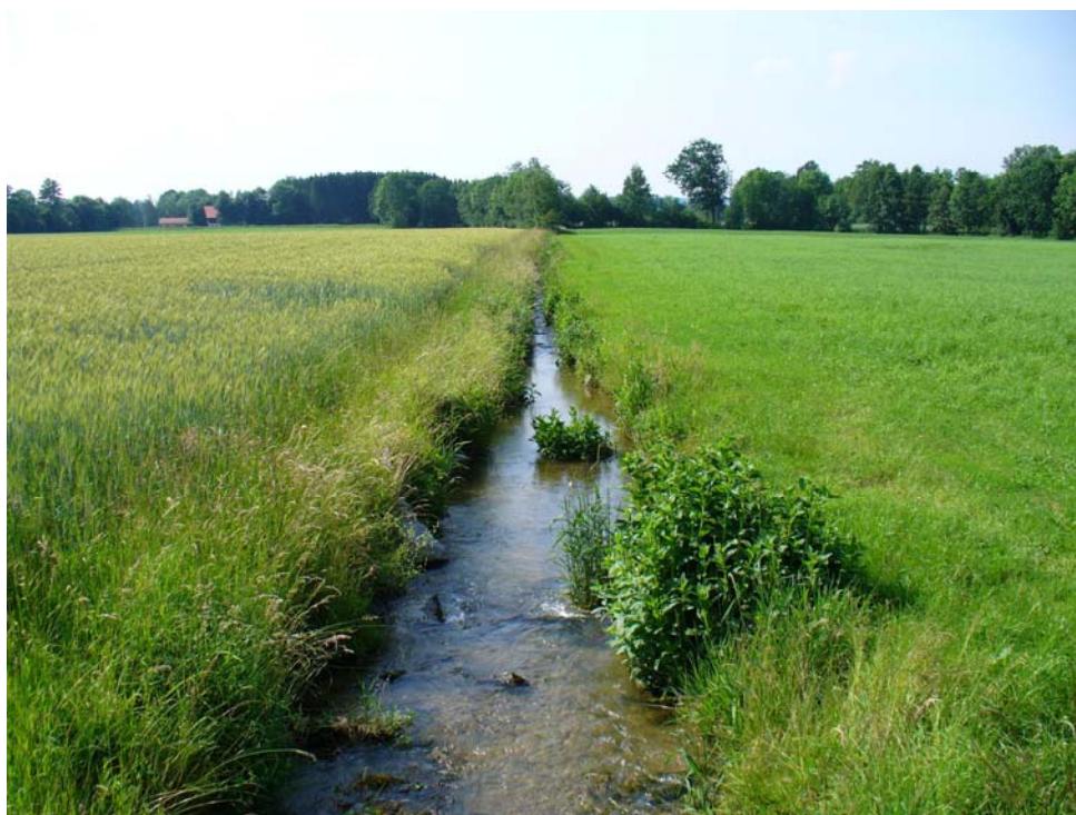
Abb. 15: Zubringer zur Mettmach, gänzlich ohne Ufergehölze, begradigt (Foto: A. Lichtenecker)
