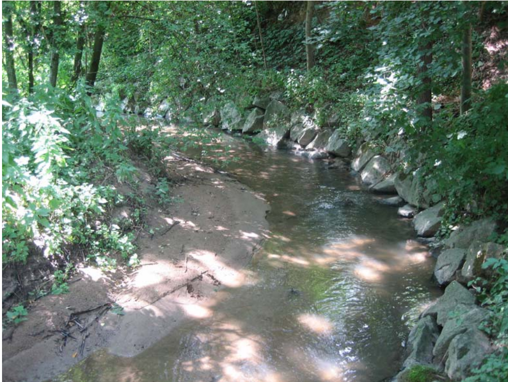
41408003: Hackinger Bach mit Blockwurf am Prallufer südlich von Oberheitzing (Foto: grün integral)
