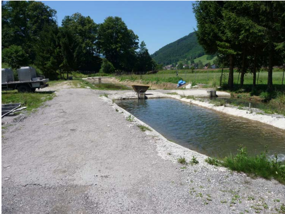
Abb. 1: Fischzuchtanlage S Sportplatz (Foto: Mag. Thomas Anzböck)
