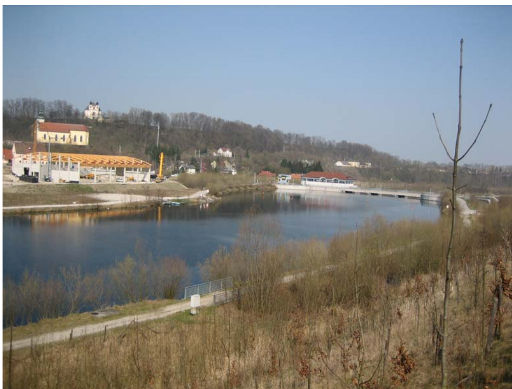
41811013: Kraftwerk Lambach mit Neupflanzungen auf den Uferböschungen der Traun (Foto: grün integral)
