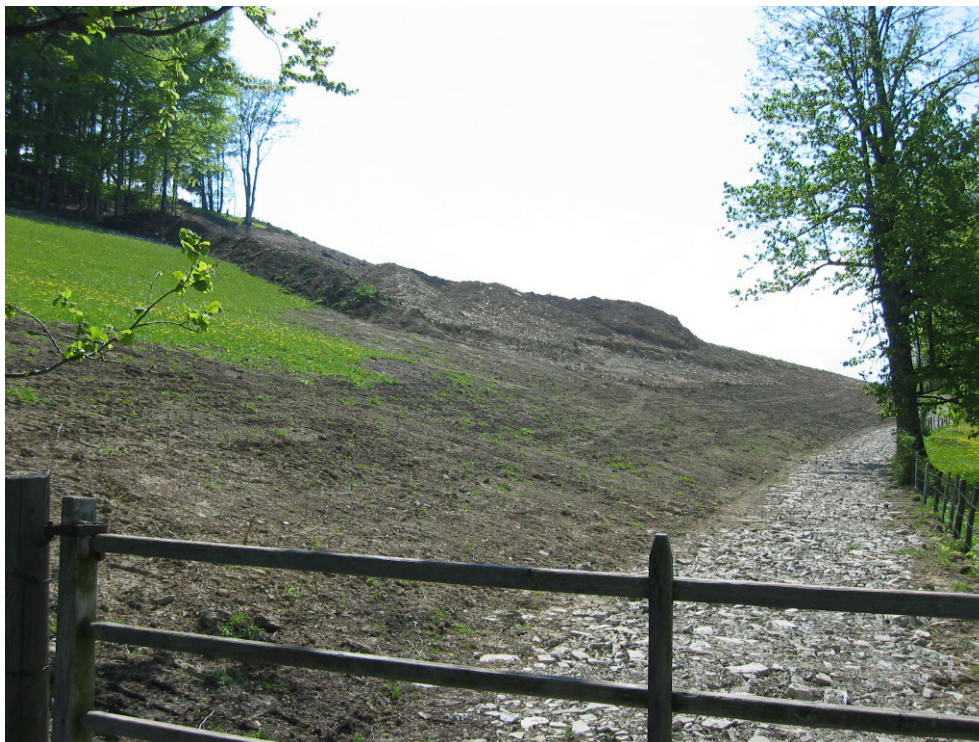
Abb.8: Gerodetes Waldstück mit neu angelegtem Feldweg. (Foto: TB Lebensraum)
