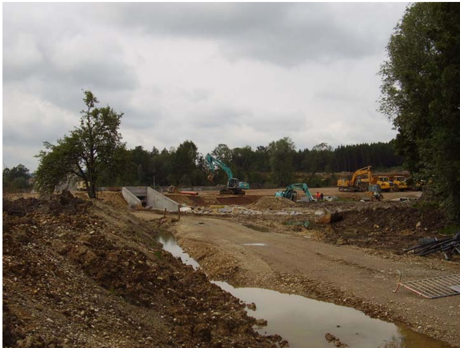
Abb. 5: Bauarbeiten zum Rückhaltebecken Hof (Foto: Technisches Büro Eisner)
