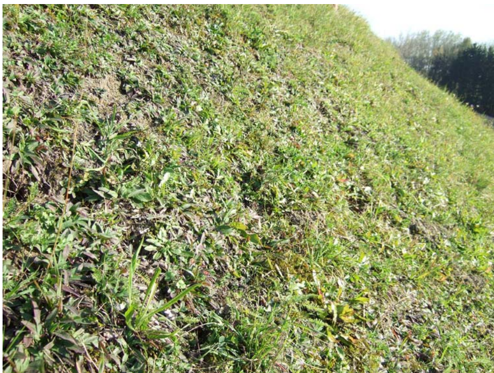
Abb. 4: Mager/Trockenböschung bei Sixberg (Foto: FREIRAUMPLANUNG STÖCKL)
