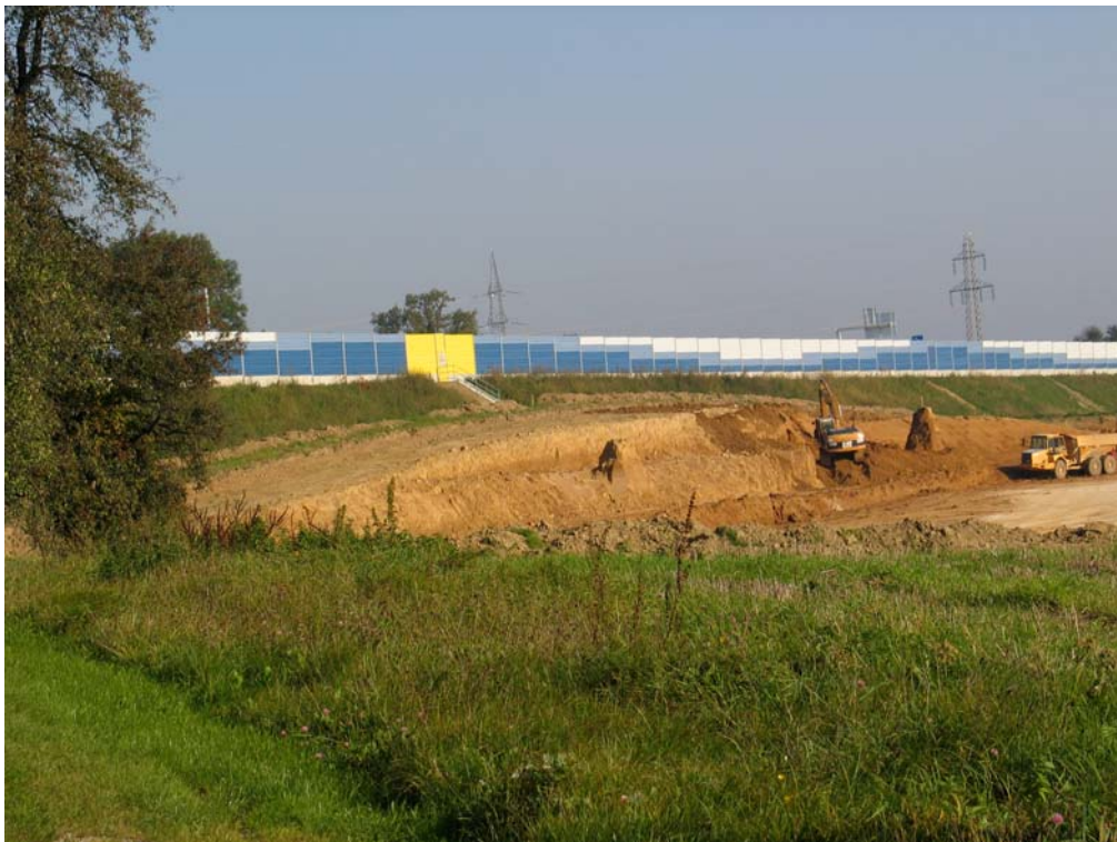
Nr 41817014: Baustelle mit Erdbewegungen entlang der A1 (Foto: grün integral)
