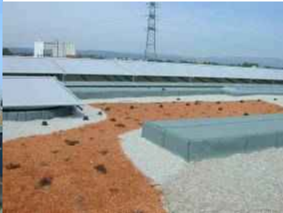
Abb. 34: Neu angelegtes Gründach über dem Biohof Achleitner in Eferding.
