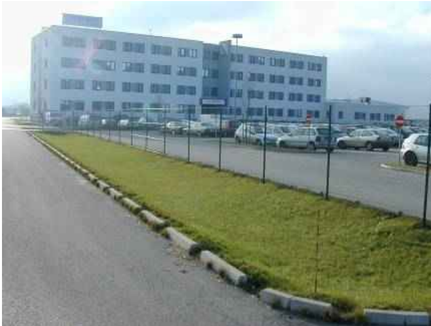
Blick von Norden auf die Rasenmulde im Winterzustand, im Hintergrund Betriebsgebäude Fa. Schenker.
