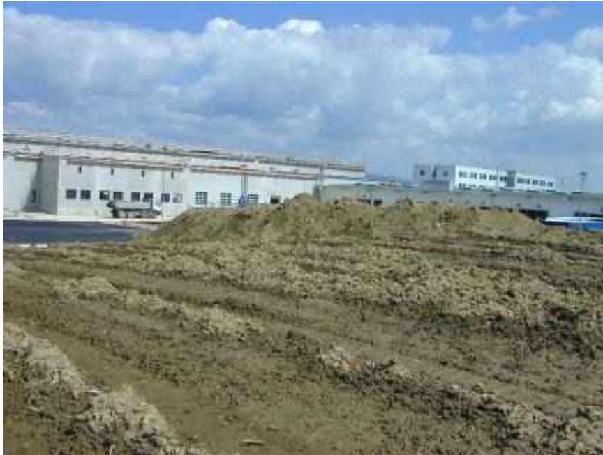
Blick von Süden, im Hintergrund rechts bestehendes Firmengebäude, links Zubau Fa. Schenker (Foto: Kumpfmüller).
