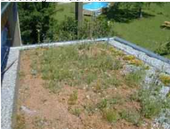
Abb. 35: Dachbegrünung mit Trockenwiesensaatgut im 2. Jahr nach der Begrünung. Büro Kumpfmüller, Steyr.
