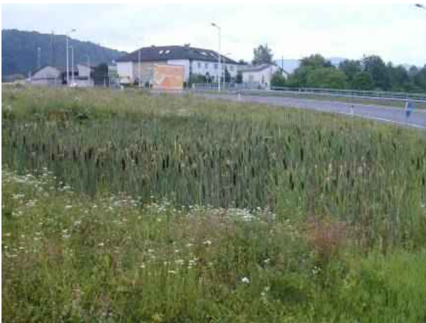
Abb. 46: Regenwasser zurückhalten: Wasserrückhaltung durch Sickermulde mit Röhricht im Gewerbegebiet Steyr-Münichholz.
