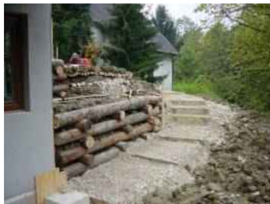
Abb. 30: Krainerwand aus Lärchenholz als Böschungssicherung.
