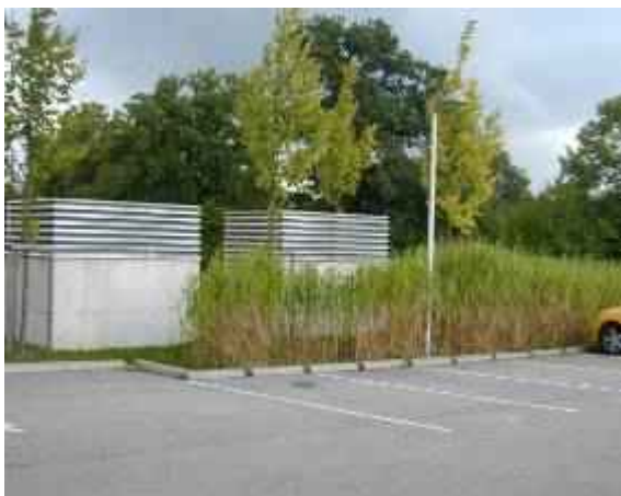
Abb. 3: Versickerungsmulde mit Röhricht beim Parkplatz des TIC in Steyr
