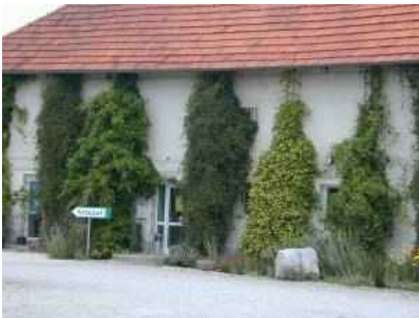
Abb. 24: Begrünung mit Stahlgittermatte. Gartengestaltung Minhard, Kronstorf.
