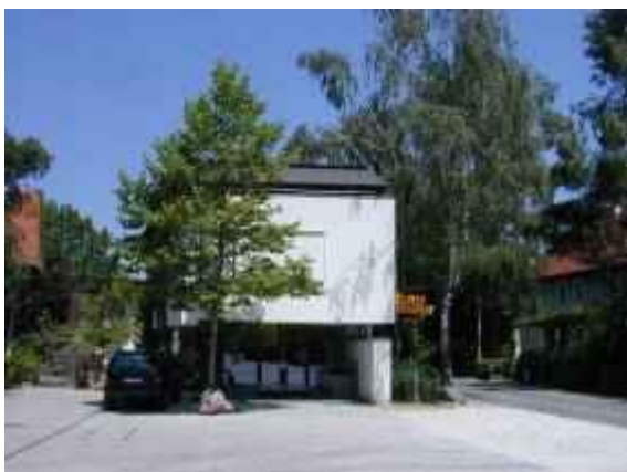
Abb. 8: Zugang mit Hausbaum. Bau Mayr Waldzell.
