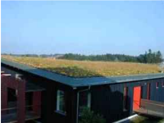
Abb. 33: Extensive Dachbegrünung auf dem Bürogebäude der Fa. Longin in Doberberg im Waldviertel.
