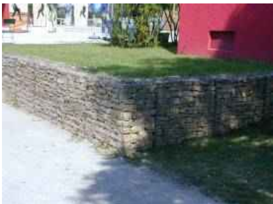
Abb. 29: Geschichtete Gabionen. Die Fugen bieten Lebensräume für Insekten, Eidechsen und trockenheitsliebende Pflanzen.
