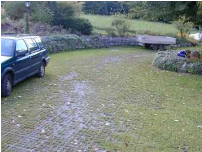
Abb. 45: Versiegelung minimieren: Befestigung des Kundenparkplatzes mit begrüntem Kunststoffgittermatten. Gartengestaltung Sailer, Pöndorf bei Straßwalchen.
