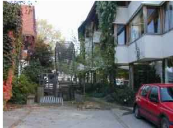
Abb. 23: Fassadenbegrünung mit verschiedenen Pflanzenarten. Bürogebäude bau mayr Waldzell.
