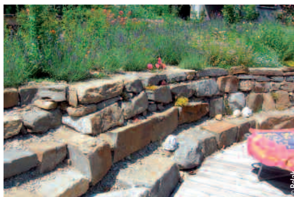
Treppe und Trockenmauer bilden den Rahmen für Blumen, die wenig Wasser, aber viel Sonne brauchen.
