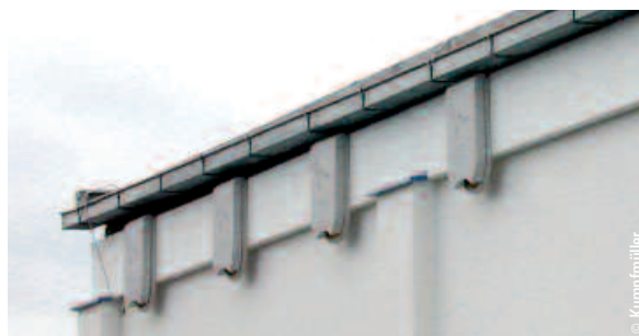
Vorgefertigte Fledermausbretter an einer Fassade, bevorzugt an einem ungestörten Ort und unter einem Dachvorsprung.
