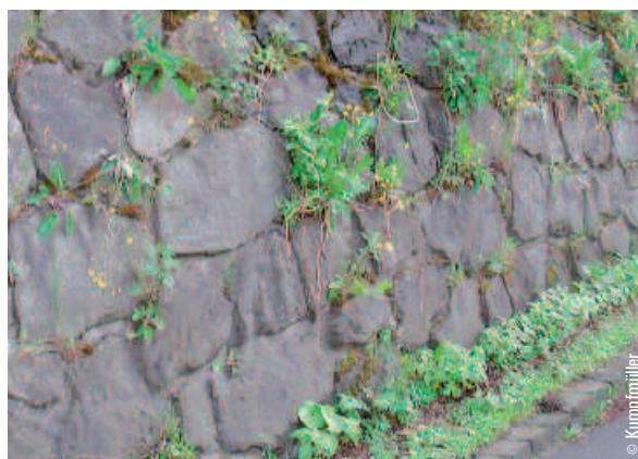
Mörtelgebundene Steinmauer: Die zurückgesetzten Mörtelfugen werden im Laufe der Jahre von genügsamen Pflanzen besiedelt.
