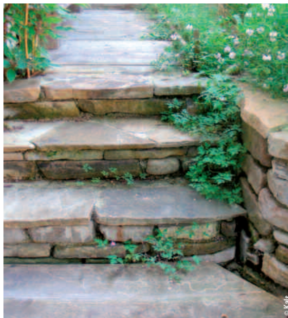
Stiege mit Legstufen aus Sandsteinplatten in gebundener Bauweise direkt am Haus.
