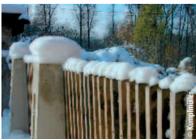
Säulen aus Sichtbeton, dazwischen eine Lattung aus quergestellten Eichenstäben. Eine dauerhaft-elegante Lösung.
