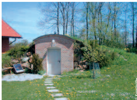
Erdkeller: in den Garten integriert durch den sanft ansteigenden, mit Wiese begrüntem Hügel.
