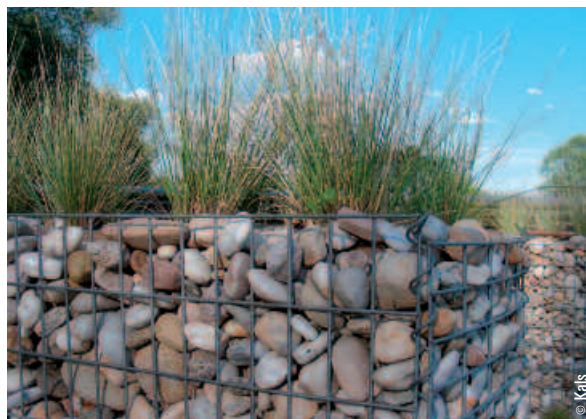
Gabionen aus Flusskieseln mit bepflanztter Krone: in naturnahen Anlagen den unbegrünteren Varianten vorzuziehen.
