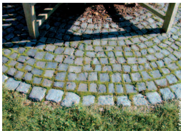
Kleinsteinpflaster in Splitt verlegt und mit Sand verfügt: Schon nach zwei Jahren haben sich die Fugen mit Moos begrünt.
