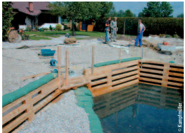
Abgrenzung zwischen Schwimbereich und Regenerationszone durch eine Holz- wand aus unbehandeltem Kantholz.
