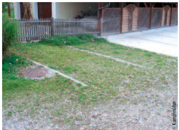
Besucherparkplatz für gelegentliche Nutzung aus Schotterrasen.
