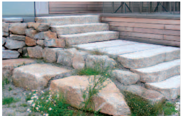
Blockstufen aus Granit mit bruchrauen Vorderkanten und sandgestrahlter Oberfläche.
