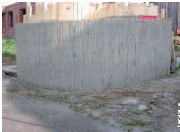
Betonstützmauer mit bewuchsfördernder strukturierter Oberfläche durch Einlage von Schilfmatten in der Schalung.
