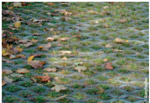
Rasengittersteine aus Beton: Die Zwischenräume werden mit sandig-magerem Substrat befüllt und eingesät.
