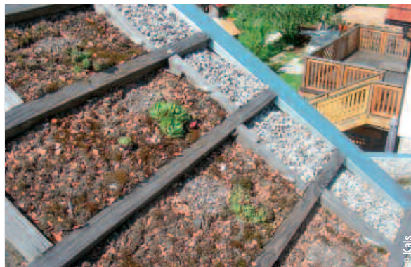
Karger Bewuchs auf südexponiertem Steildach; das Substrat wurde mit Schubswellen stabilisiert.
