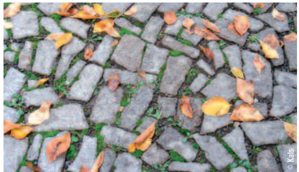
Wildpflaster aus unsortierten Bruchsteinen. Die unterschiedlich breiten Fugen ermöglichen eine große Pflanzenvielfalt.
