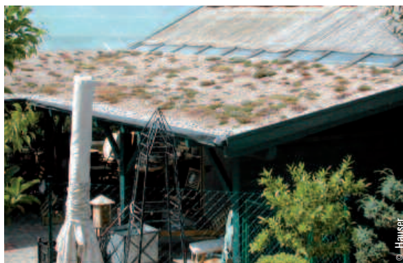
Begrüntes Vordach über einem Sitzplatz mit Bewuchs aus Mauerpfeffer (Sedum) und Hauswurz (Sempervivum).
