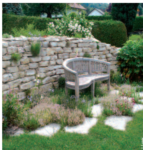
Sitzplatz vor Trockenmauer aus Granitplatten mit Kräuterfugen.
