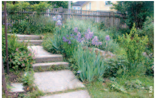
Vor Ort geschaltete und gegossene Betonblockstufen mit breiten begrünten Fugen.
