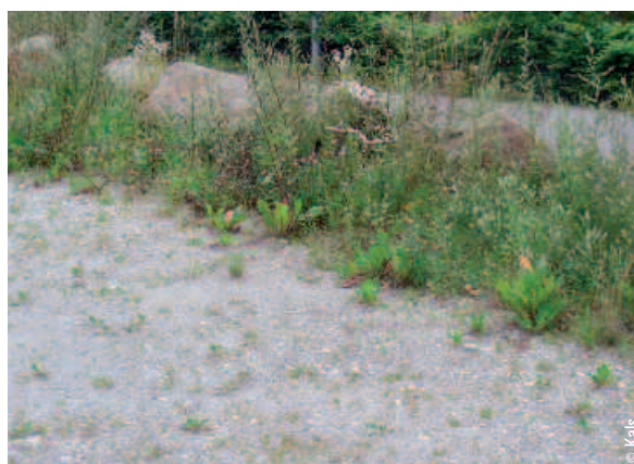
Schotterrassen: spärlicher Bewuchs auf häufig befahrenen Flächen, intensiver Bewuchs am Rand.
