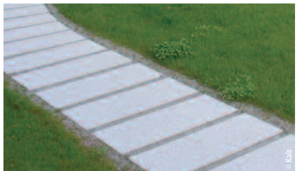
Exakt geschnittene Granitplatten mit Fugen und Randeinfassung aus Flins wenige Monate nach der Verlegung mit beginnender Begrünung
