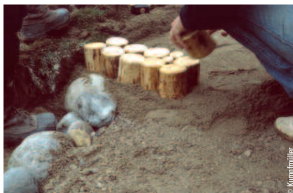
Verlegung von Hirnholz in Splittbett
