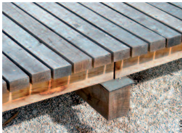
Fünf Zentimeter starke Eichenbohlen auf einer Tragekonstruktion aus Kanthölzern im Kiesbett.
