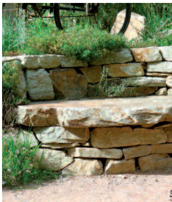
Geschichtete Trockenmauer aus plattigen Bruchsteinen mit integrierter Sitzbank
