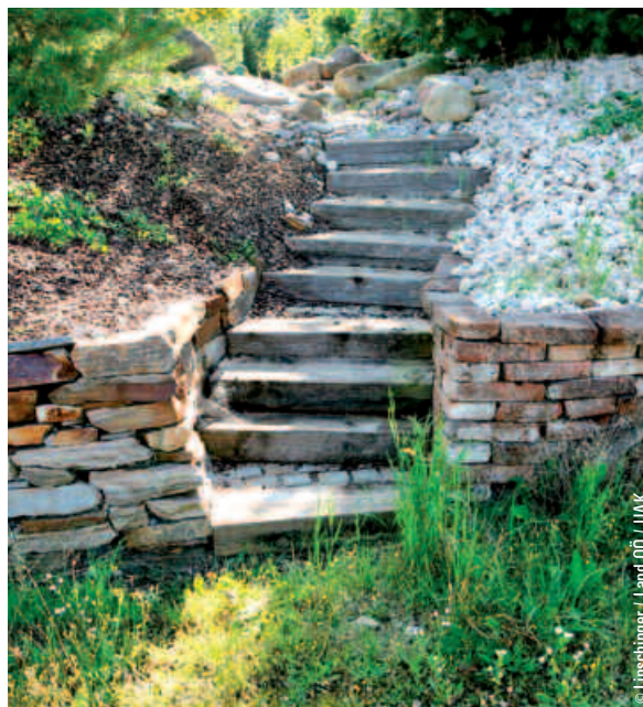
Holzblockstufen in eine Trockenmauer eingefügt.
