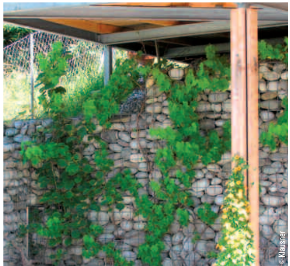
Gabionenwand mit Flusskieseln als Hangabstützung vom Mauerfuß her mit Wein begrünt.
