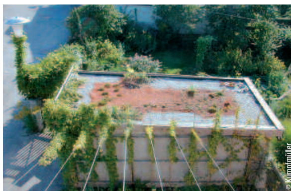
Sanierung eines alten Garagendaches mit Kautschukfolie und Extensivbegrünung einige Wochen nach Fertigstellung.
