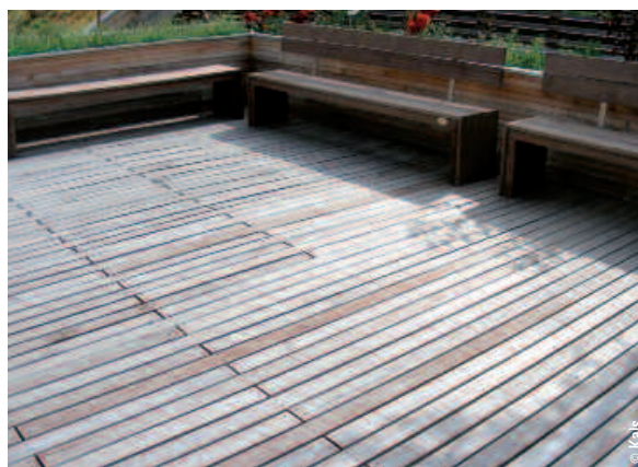
Terrasse aus unbehandeltem, silbergrau verwittertem Eichenholz mit versetzt angeordneten Stoßfugen.
