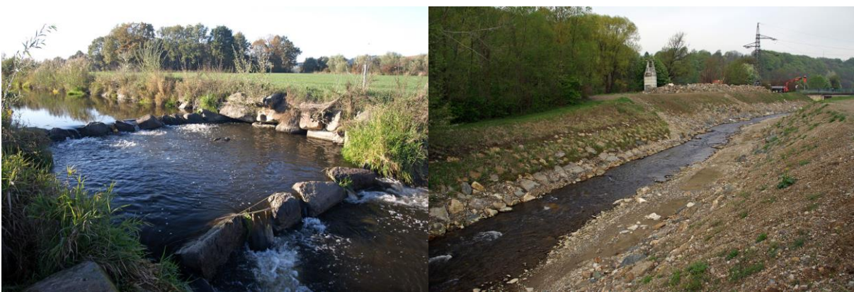
Abb. 40: Links: Obere Riegelrampe an der Leitenbach-Mündung; Rechts: Asymmetrische Rampe, die auch für Goldsteinbeißer passierbar ist (Gamlitzbach-Mündung, Südsteiermark).
