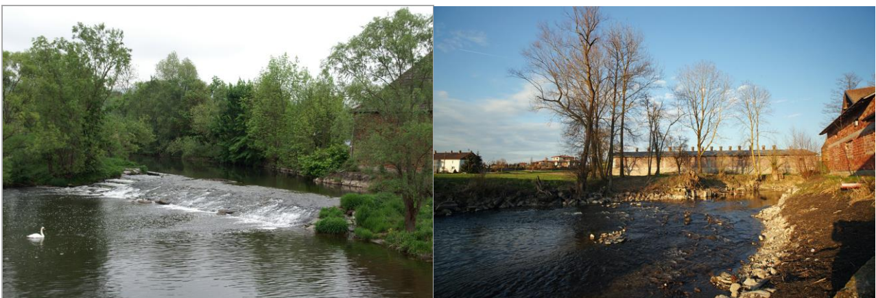
Abb. 39: Links: Aschach-Wehr in Hacking mit integrierter Fischaufstiegshilfe, die für Goldsteinbeißer und andere Arten als nicht passierbar einzuschätzen ist. Rechts: Beispiel für ein rückgebautes Wehr an der Pram bei Heitzing.
