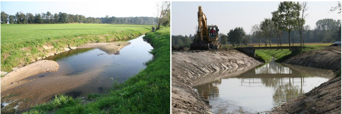
Abb. 57: Sandfang im Deimingerbach mit Granitsandablagerungen und Steinbeißervorkommen (links) und geräumter Sandfang im Thurnhoferbach (rechts) im Machland 2009.
