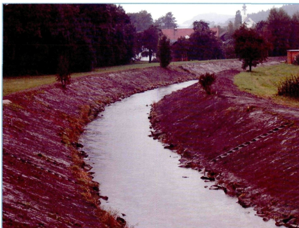
Abb. 3.2: Im Jahre 2001 wieder hergestelltes Regulierungsprofil der Trattnach bei Taufkirchen an der Trattnach
