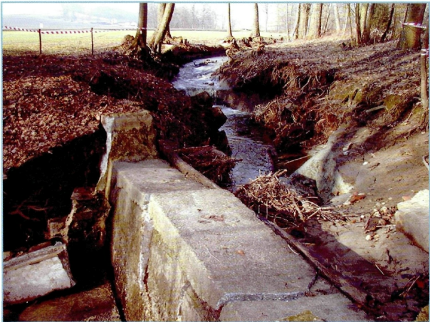
Abb. 7.4: Das Bauwerk Nr. 3-12 wurde durch ein Hochwasser zerstört, der Bach strömt unter dem Wehrfuß hindurch
