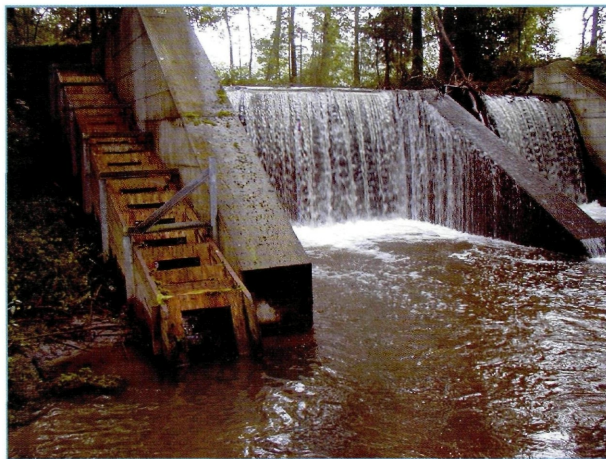
Abb. 5.39: Im Ortsgebiet von Weibern ist ein - infolge Verklammerung funktionsuntüchtiger - Denil-Pass installiert
