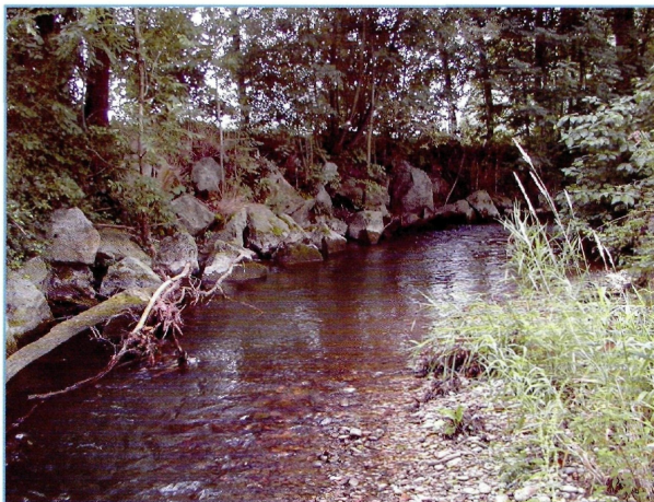
Abb. 6.7: Flussaufwärts von Hofkirchen an der Trattnach sind fast alle Prallufer massiv gesichert
