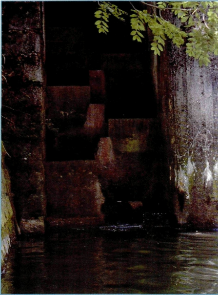
Abb.7.2: Sämtliche Beckenpässe dieser Bauart an der Trattnach sind als nicht funktionsfähig zu beurteilen
