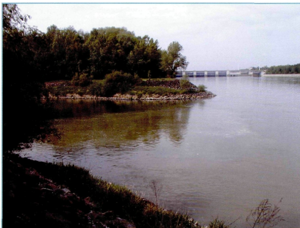
Abb. 5.6: Die Mündung des Innbaches wurde ins Unterwasser des Kraftwerkes Ottensheim-Wilhering verlegt.
