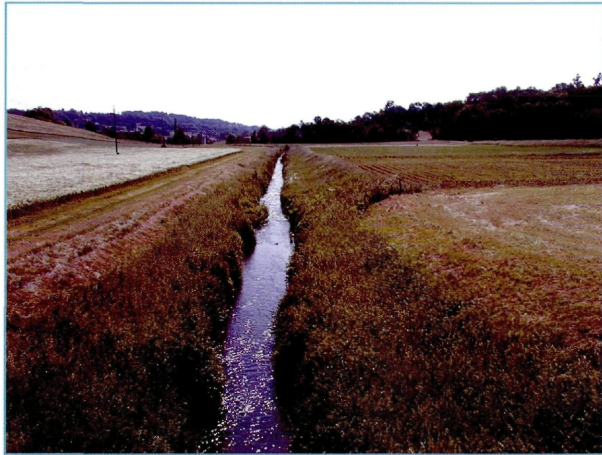
Abb. 6.6: Flussaufwärts der Ortschaft Furth ist die Polsenz infolge der durchgehenden Ufer- und Sohlssicherung kanalisiert
