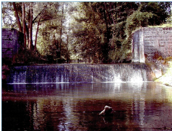
Abb. 5.37: Die Regulierungswehre sind über die gesamte Breite von einem zu geringen Wasserkörper überströmt
