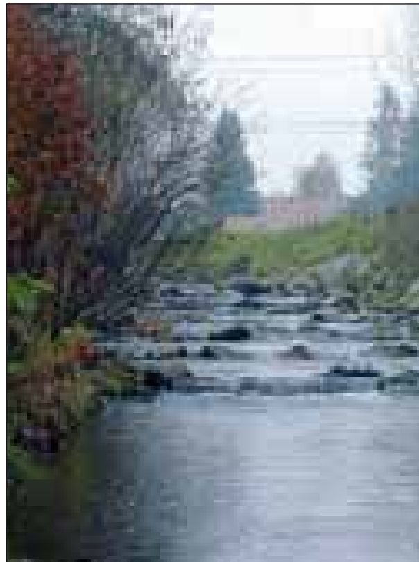
Abb. 91: Aufgelöste Rampe im Rieder Bach, die zur Herstellung des Längskontinuums errichtet wurde
