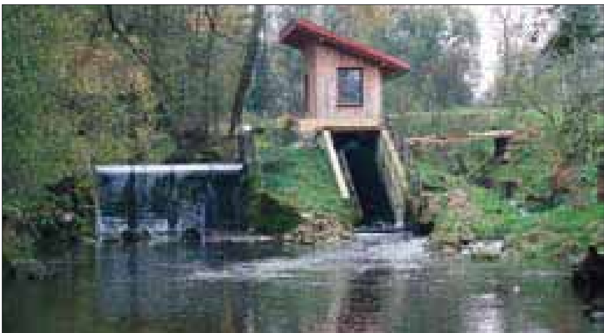
Abb. 86: Durch den Aufstau der fließenden Welle bei Kraftwerksanlagen kommt es zu massiven Feinsedimentablagerungen im Stauraum
