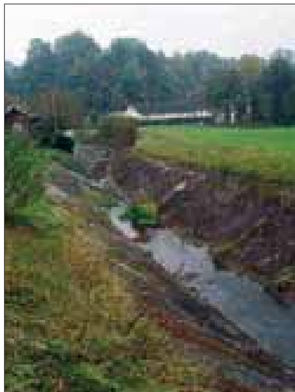
Abb. 62: Der Doblbach wird in seinem Unterlauf in einem kanalisiertem Bachbett geführt
