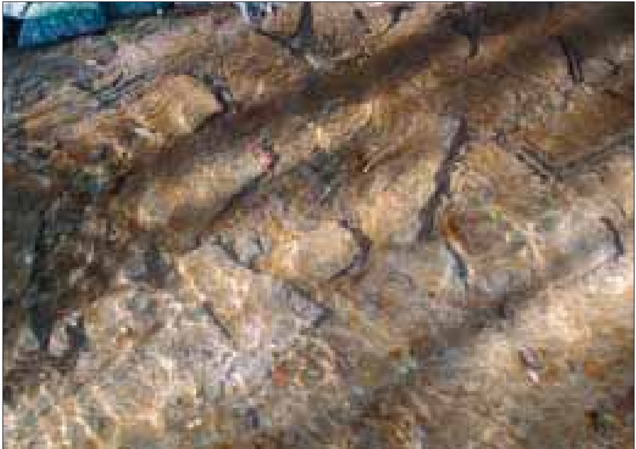
Abb. 74: Sohlstabilisierung durch Wasserbausteine
