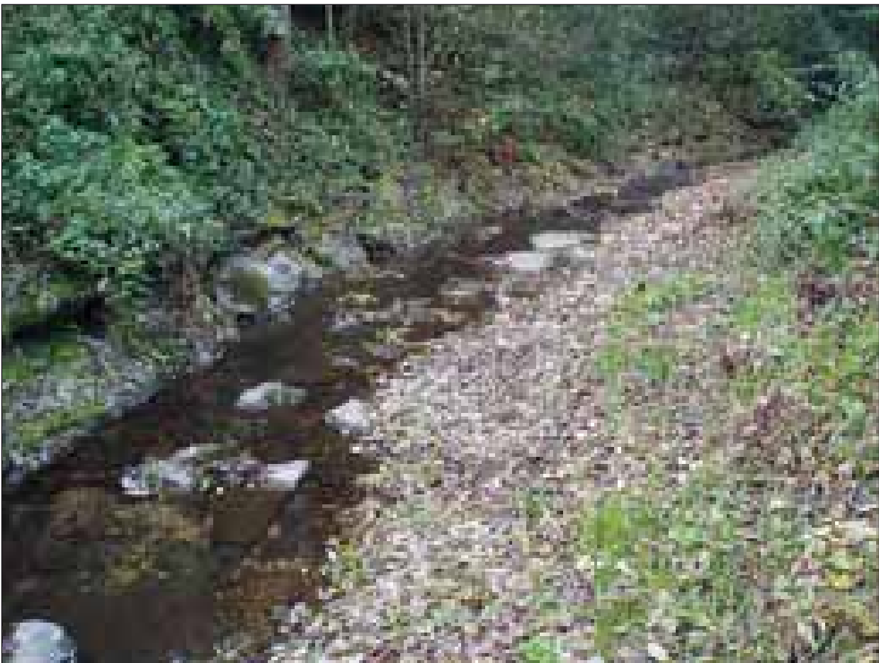
Abb. 42: Blockwurfsicherung im Nonsbach
