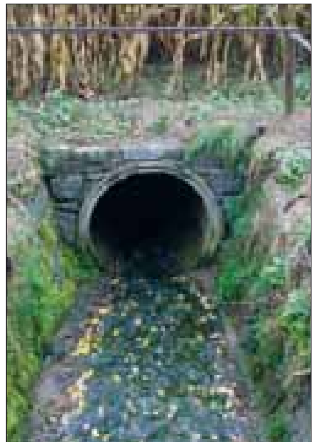
Abb. 85: Flussaufwärtiges Ende der Verrohrungsstrecke im Murhamer Bach
