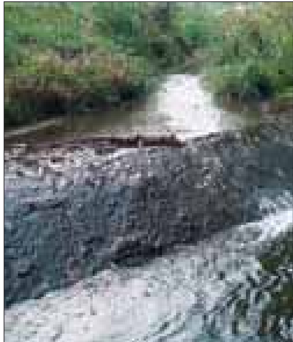
Abb. 41: Die Konnektivität mit dem Nonsbach ist durch die Uferverbauung des Gurtenbaches unterbrochen
