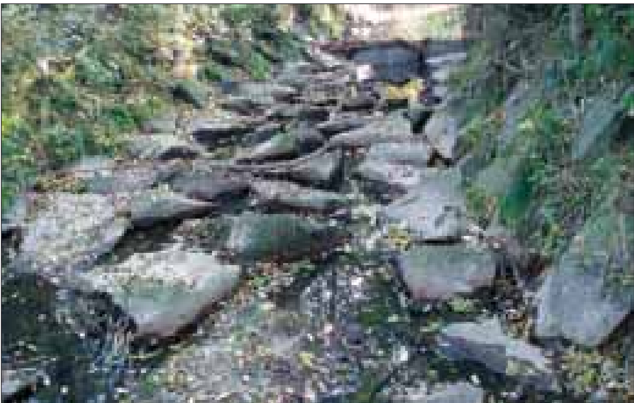
Abb. 18: Querbauwerke, die von einer Vielzahl kleiner Wasserkörper durchströmt sind, sind für Fische unpassierbar (Foto: Nonsbach)
